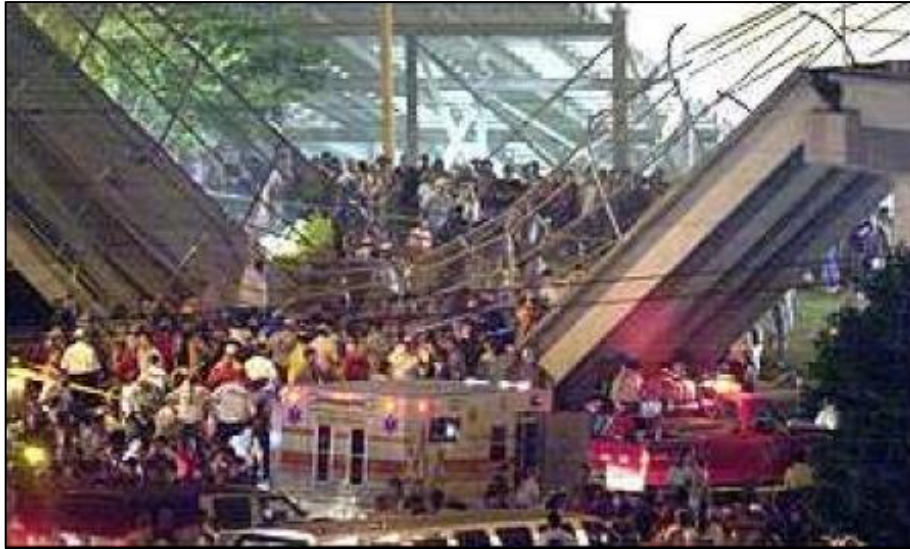
Figura 1.2 - Desabamento de uma passarela na Carolina do Norte/EUA (BBC News apud Faisca, 2003).
