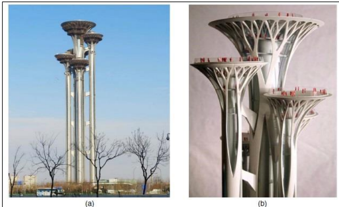
Figura 2.5 - Torre de Vigia Olímpica de Beijing: (a) perfil; (b) plataformas de turismo no topo da torre (Zhang et al , 2017).
