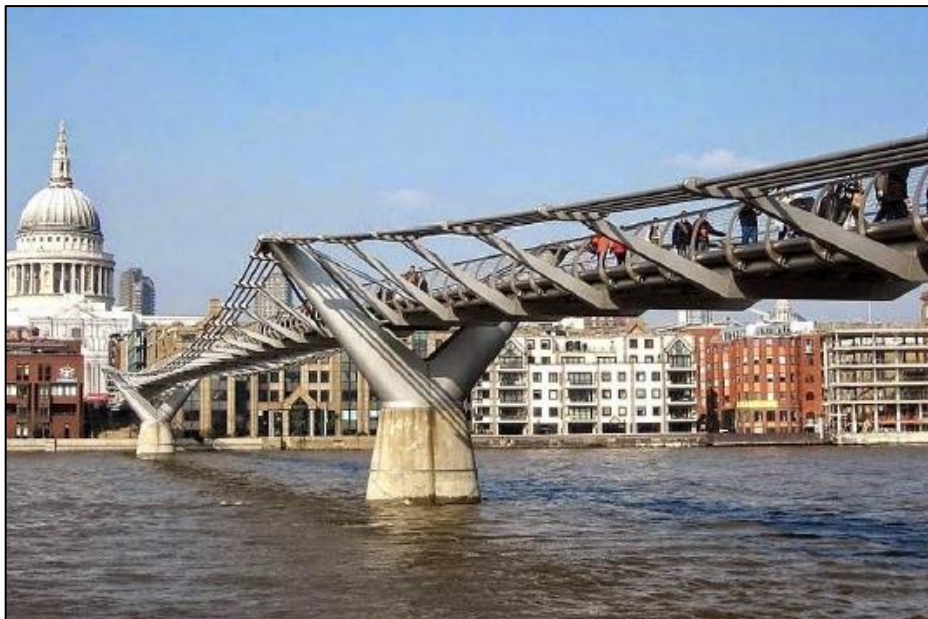
Figura 1.1 - Passarela Millenium, Londres, Inglaterra (Pereira, 2017).
