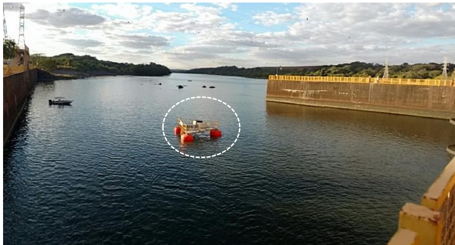
Figura 5.8 – Turbinas instaladas em Bariri-SP
