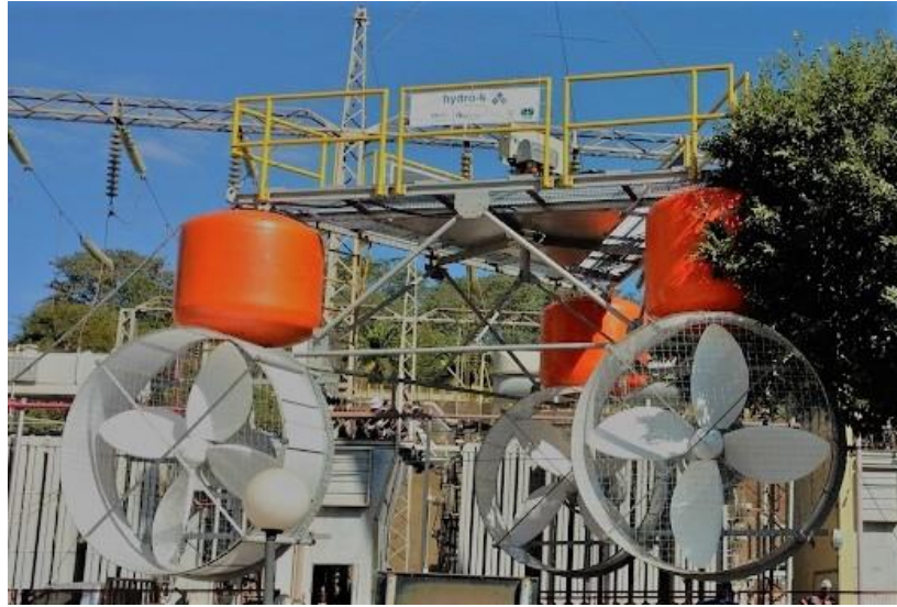
Figura 5.7 – Instalação de turbinas em tamanho real em Bariri-SP
