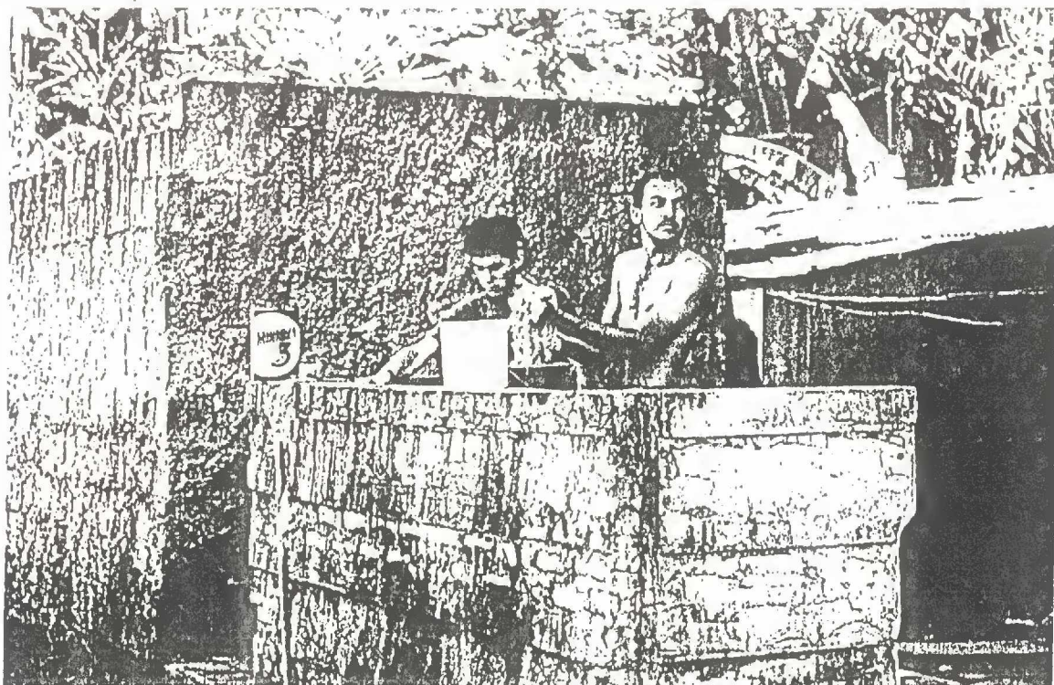
[Foto 7 Tanques Coletivos Fonte: Zarat]
