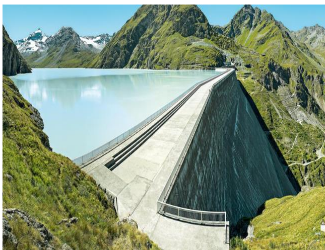
Figura 1-1. Barragem gravidade de concreto – Grande Dixence – Suíça [Grande-dixence.ch].
