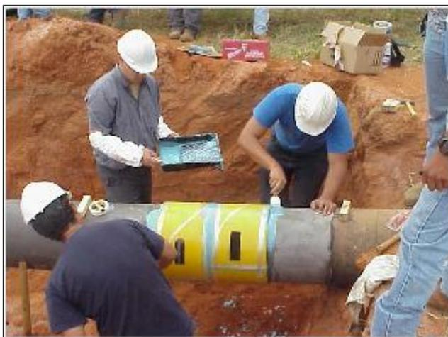
**Figura 2. 2 - Aplicação da manta compósita.**
