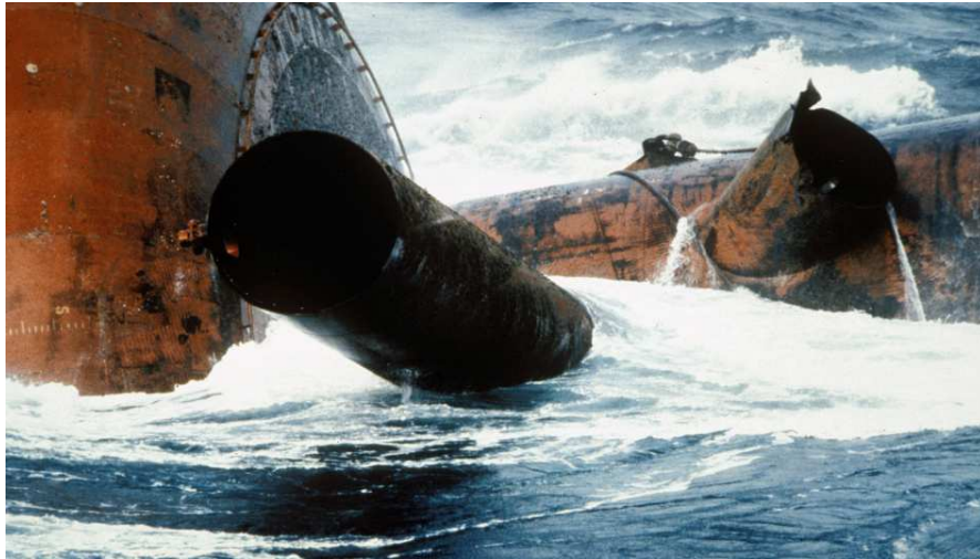
Figura 1-5 - Coluna D e o contraventamento D6 da Kielland . (Museu Norueguês do Petróleo).
