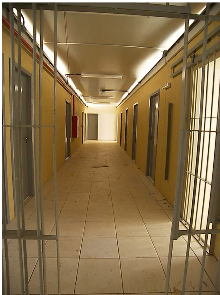
Figura 78 – Sistema adotado na ala de triagem da Penitenciária de Criciúma (SC), sem circulação aérea de agentes
