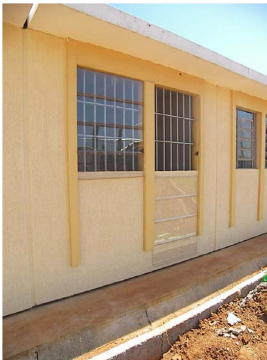
Figura 89 – Janelas das Celas com grades cementadas e policarbonato
