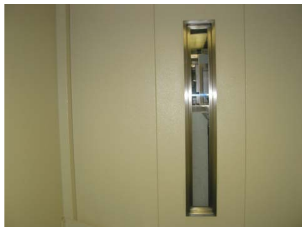
Figura 95 – Sistema de iluminação
