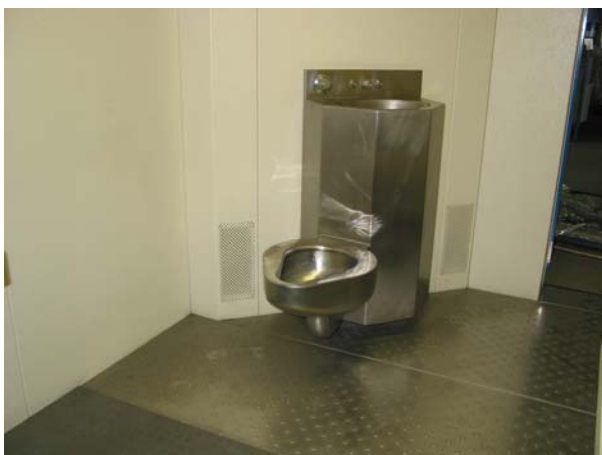
Figura 94 – Conjunto lavatório e vaso sanitário
