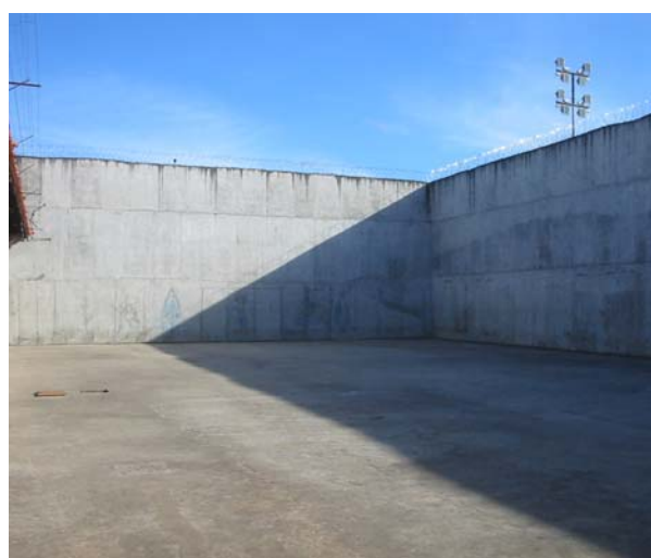
Figura 48 – Pátio de Sol: Muros altos com concertina em seu topo
