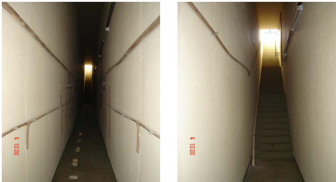
Figura 57 – Corredor de acesso ao Posto de observação do agente
