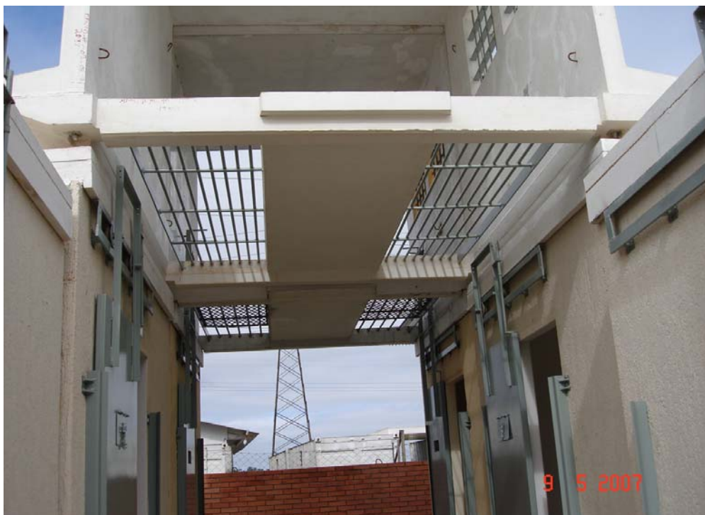
Figura 77 – Protótipo proposto pela fábrica: Dois conjuntos de celas e um módulo de passarela.
