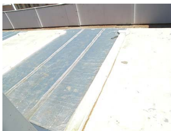
Figura 76 – Tratamento térmico das coberturas
