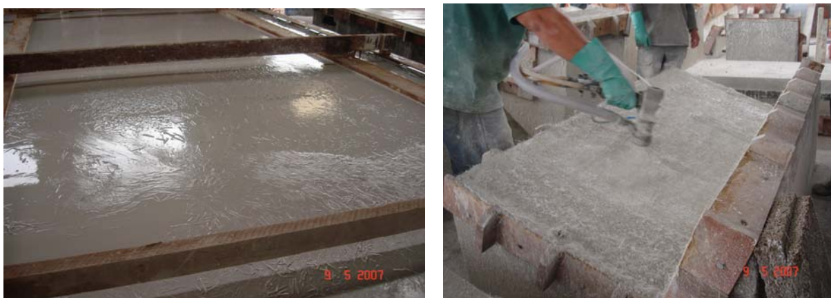
Figura 71 – Fôrma para painel em CAD e introjeção de fibras de vidro no GRC
