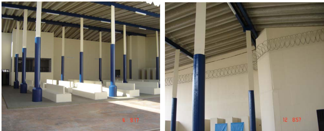
Figura 65 – Seção triangular dos pilares no pátio
