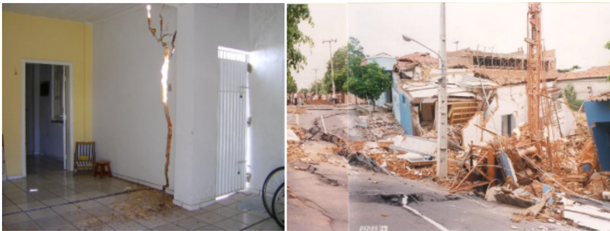
Figura 2.3. Subsidência ocorrida no centro da cidade de Teresina, PI.
