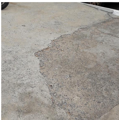
Figura 12 - Patologia_Fragmentação. (Autor, 2018)
