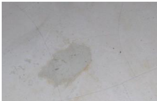
Figura 13 - Patologia_Manchamento. (Camargo, 2010)
