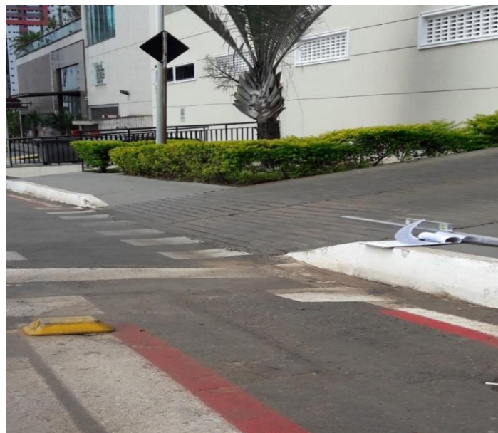
Figura 39 - Inclinação de rampa de garagem interferindo na rota acessível. (Autor, 2018)
