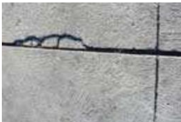
Figura 09 - Patologia_Esborcinamento. (Rodrigues, 2011)
