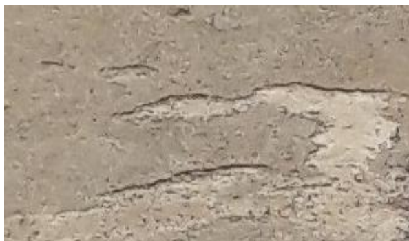
Figura 08 - Patologia_Delaminação. (Autor, 2018)
