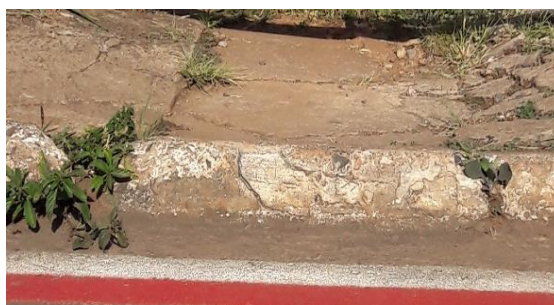
Figura 14 - Patologia_Recalque. (Autor, 2018)
