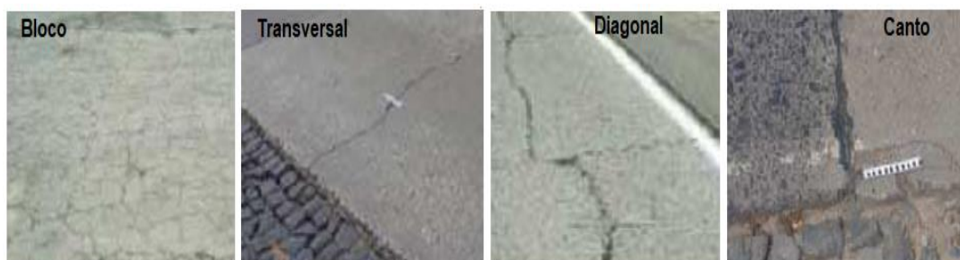
Figura 11 - Patologia_Fissuras. (Rodrigues, 2011)
