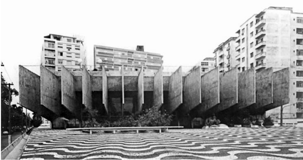
Figura 196. Clube XV, Santos – SP. Obra construída. Autores: Pedro Paulo de Mello Saraiva e Francisco Petracco Fontes: Acima - Acrópole, n.366, out. 1969. Abaixo – Acervo Francisco Petracco.
