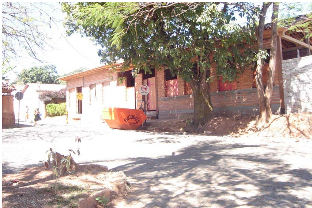
Figura 25. Residência, Rua Santa Cruz ano agosto/2006. Foto: da autora.
