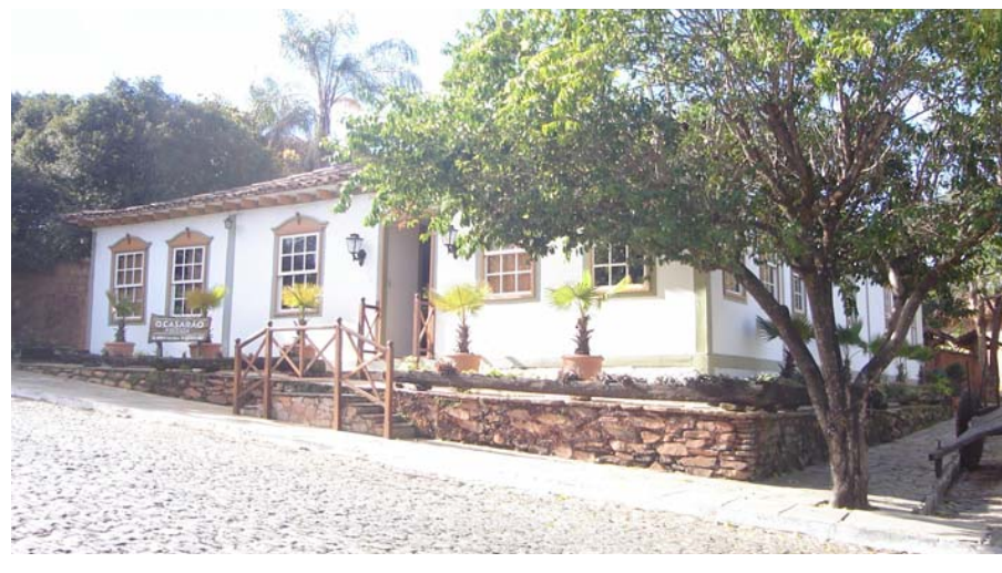
Figura 16b. Residência ao final da Rua Direita, 2005. Foto: João Guilherme Curado.
