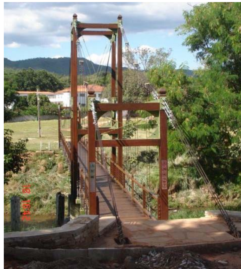
Figura 3b. Ponte pênsil sobre o rio das Almas, 2005. Foto: Ulisses Jayme Neto.
