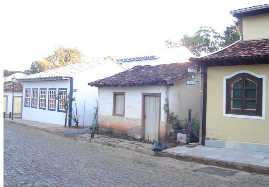
Figura 11b. Residência, Rua Pireneus, 2006 Foto: da autora.
