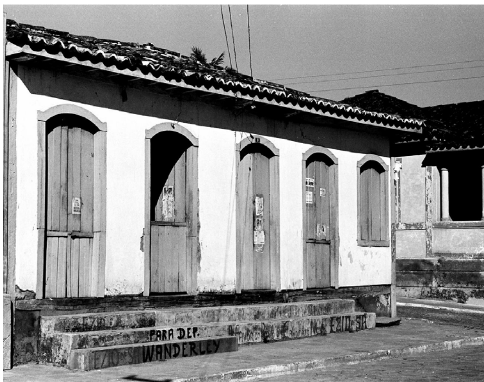
Figura 32a. Edificação mista à Rua Direita, década de 1970. Foto: arquivo CEDiarTE - FAU/UNB -
