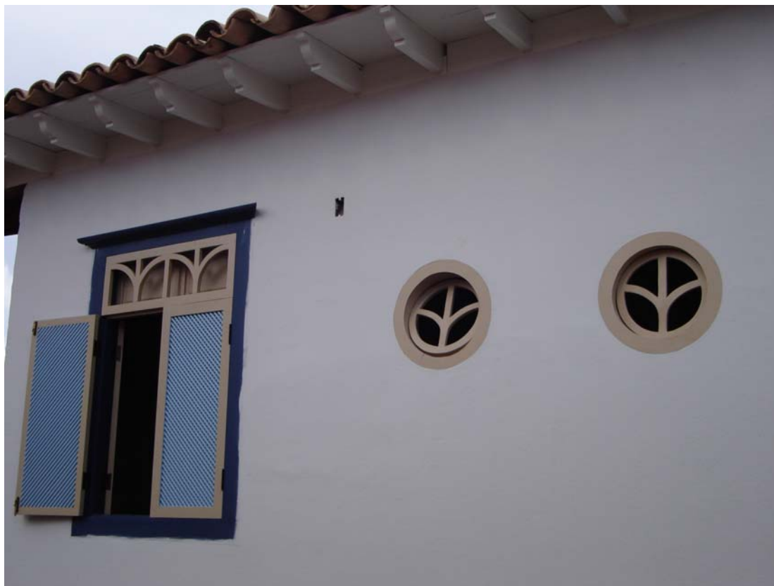
Figura 3. Detalhe de construção do século XXI, esquina com Rua Pireneus, centro histórico, 2006. Foto: da autora.
