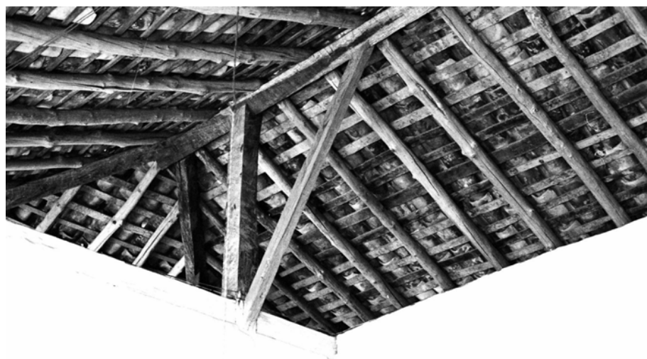
Figura 18a. Detalhe: madeiramento do telhado e telhas; década de 1970. Foto: Arquivo CEDiarTE - FAU/UNB.
