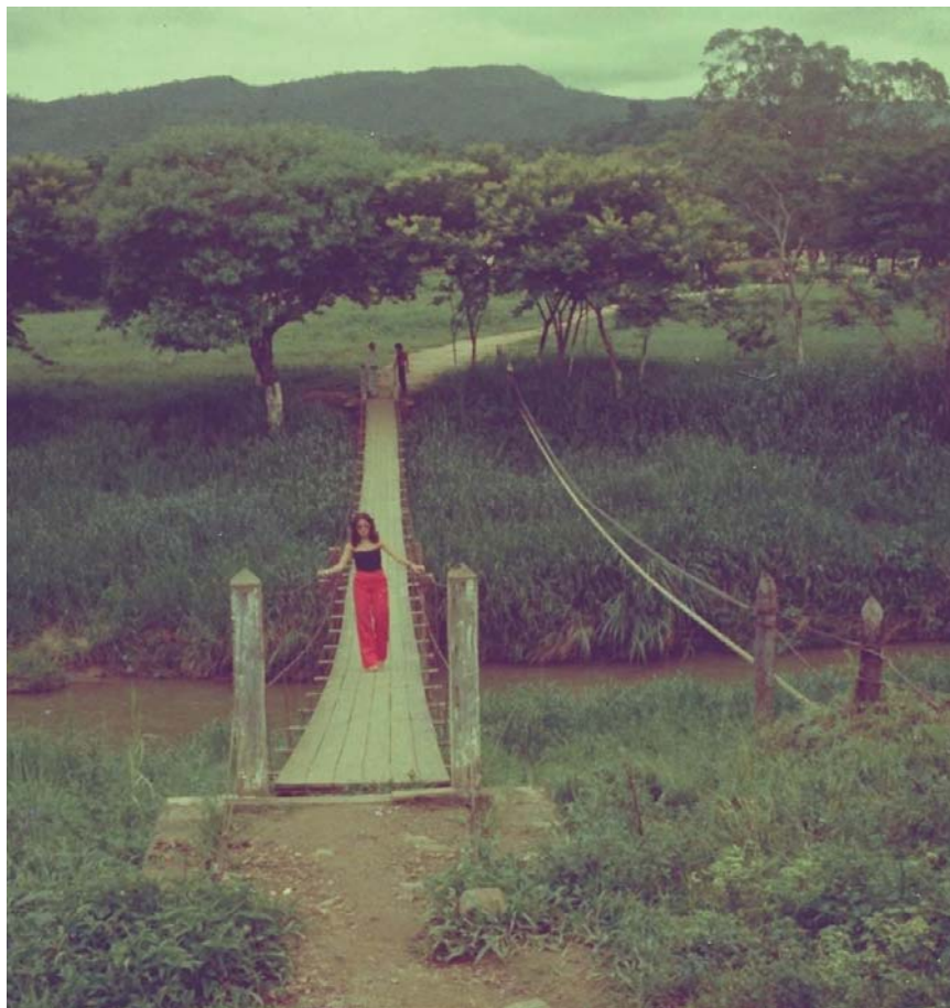
Figura 2a Ponte pênsil sobre o rio das Almas, 1978. Foto: Valdomiro de A. Godinho.
