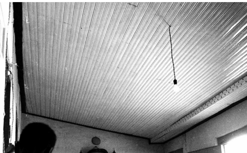
Figura 18b. Detalhe de forro com "ventilador", década de 1970. Foto: Arquivo CEDiarTE - FAU/UNB.
