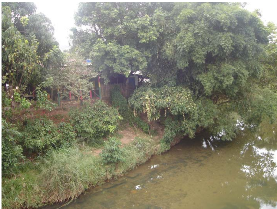
Figura 10a. Edificação à margem do rio das Almas próxima à ponte de madeira, 2006. Foto: da autora.
