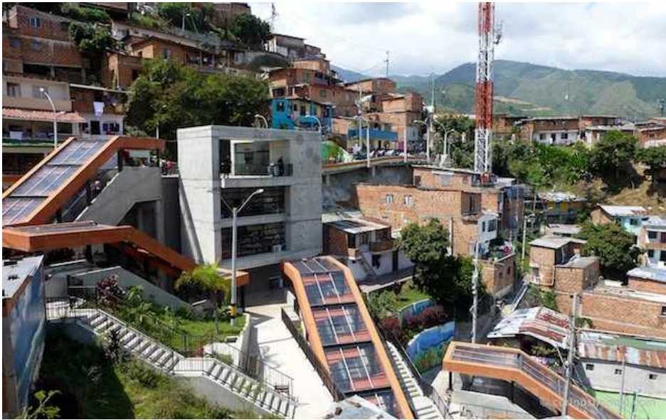
Figura 8 - Escadas elétricas comuna 13 Medellín.
