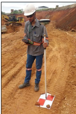
Figura 4.14 Locação e Retirada de Coordenada de Ponto de Controle
