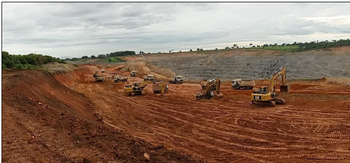
Figura 4.7 Frente de Lavra de Estéril na Cava Norte
