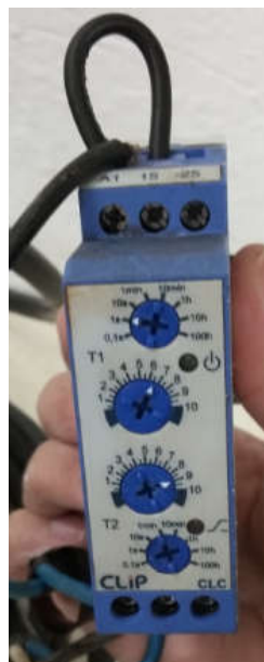
Figura 3.25. Temporizador, responsável pela frequência do carregamento.
