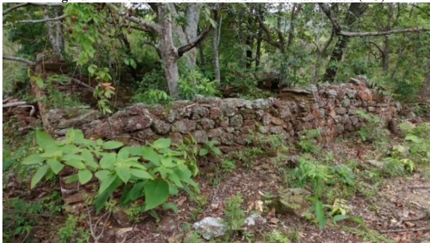
Figura 29 – Ruína de Residência - Serra da Natividade (TO)
