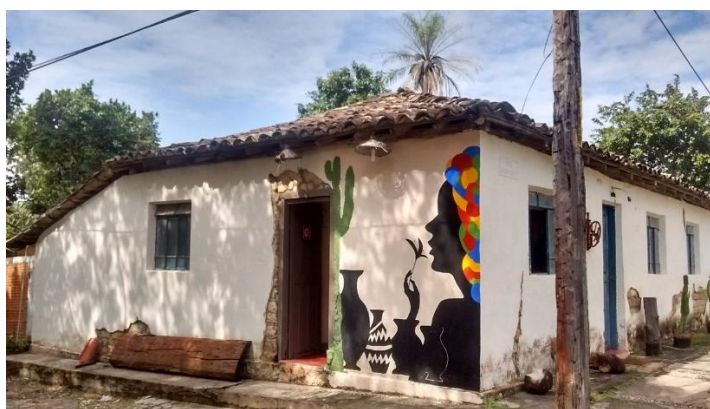
Figura 42 – Casa antiga em Cavalcante (GO)
