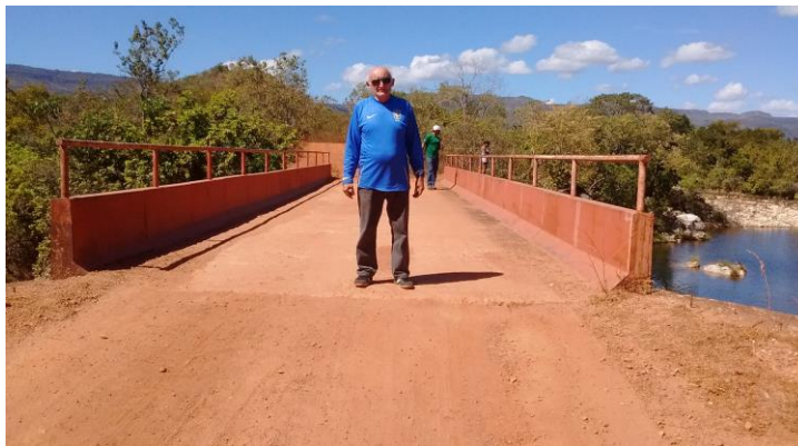
Figura 107 – Ponte sobre o Rio Prata que divide os Estados de Goiás e Tocantins
