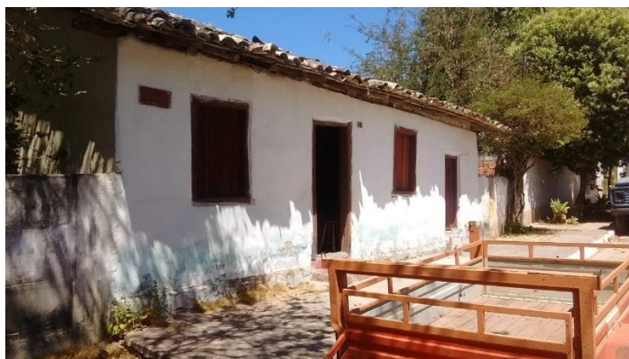
Figura 43 – Casa antiga em Cavalcante (GO)
