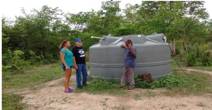
Figura 142 – Reservatório de água na residência do Senhor Mochila no Vão do Moleque
