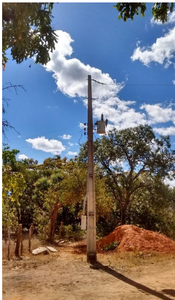
Figura 110 – Instalação de postes de luz no Vão de Moleque – sem energia
