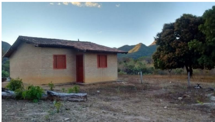
Figura nº 82 – Residência de Alvenaria na Comunidade Diadema
