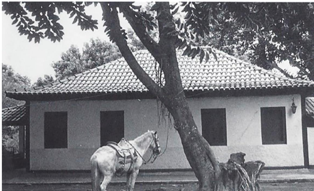
Figura 20 – Antiga sede de fazenda: Capão dos Porcos.
