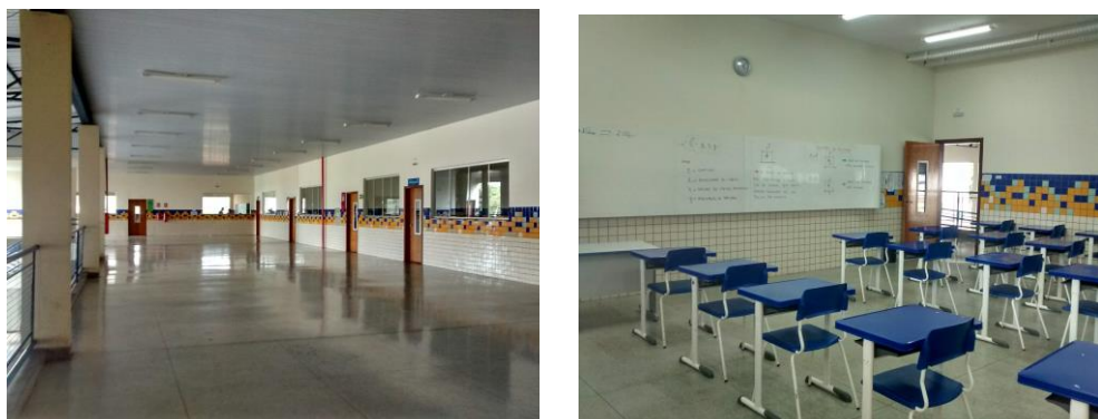
Figura 49: Revestimento cerâmico com faixa colorida, presentes exclusivamente na fachada e interior das salas de aula da escola.
