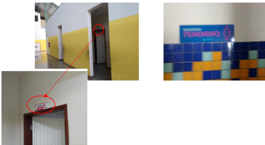
Figura 27 - Placas de identificação em sanitário da escola 01 (à esquerda) e em sanitário da escola 02 (à direita)
