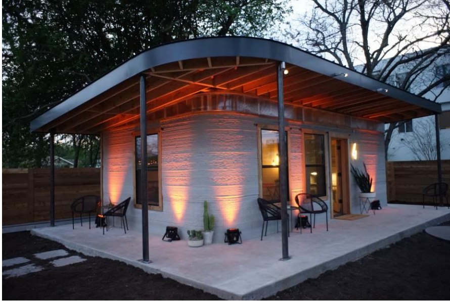
Figura 24 – Residência de interesse social, New Story. Fonte: https://www.iconbuild.com/
