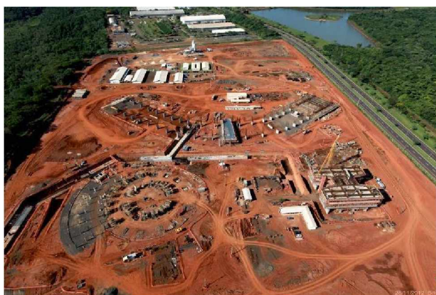
Figura 3.3 - Exemplo de canteiro de obras 'limpo' e 'limpas' (desmatadas) dentro da zona de construção se toranam
