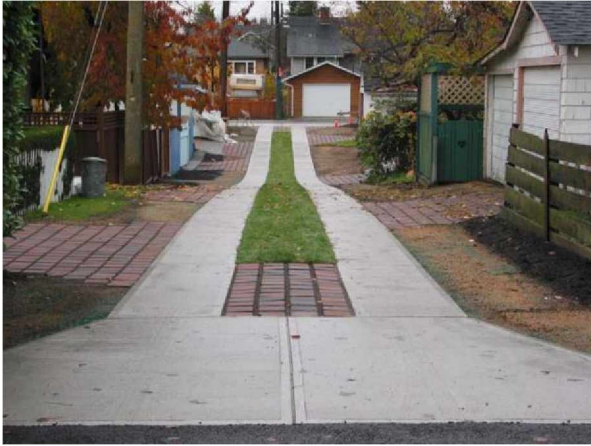
Figura 3.13 - Rua de acesso residencial em Vancouver que utiliza uma combinação de concreto com pavimentos vazados e grama. fonte: HINMAN, 2012
