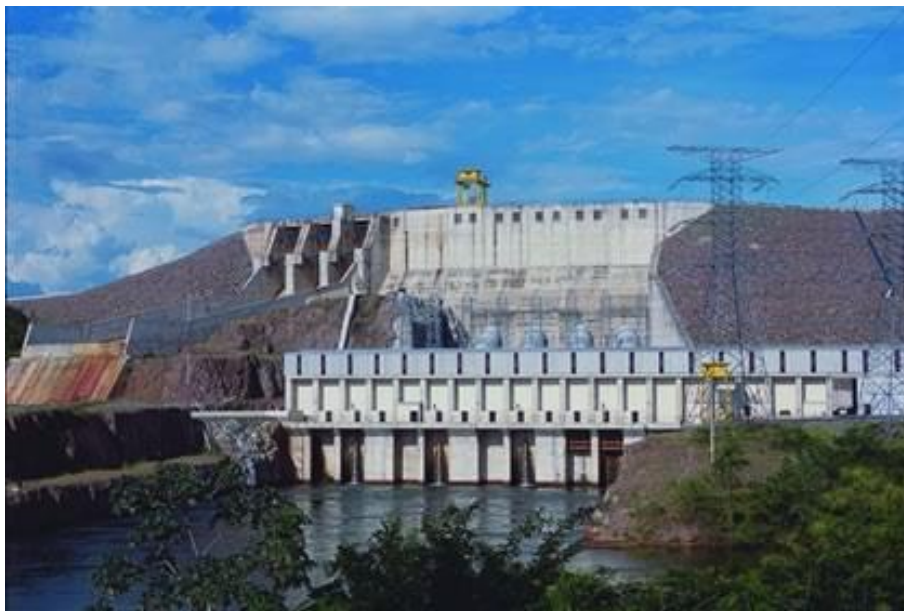
Figura 3.6 – Vista das estruturas de concreto de Manso.
