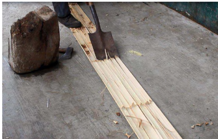
Figura 58: Detalhe da cobertura com esteira de bambu e manta asfáltica
