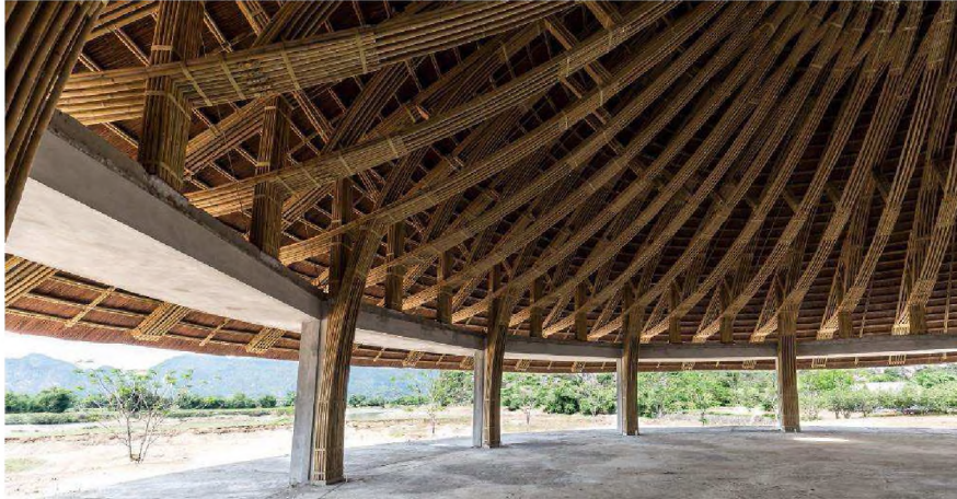
Figura 84: Peças posicionadas Fonte: Bambuild, 2017
