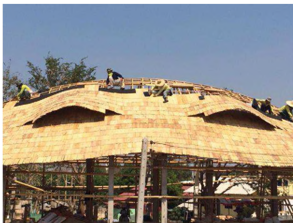
Figura 59: Detalhe da cobertura com esteira de bambu e manta asfáltica
