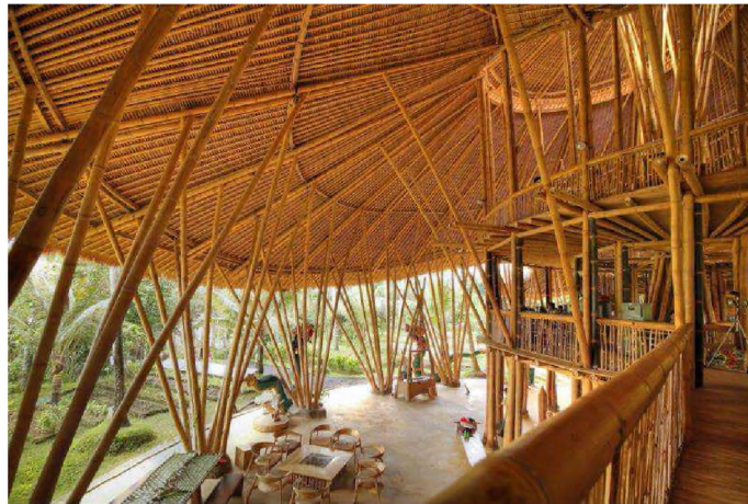
Figura 12: Parte da estrutura principal da Green School.
