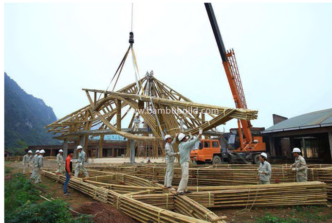
Figura 83: Posicionamento das treliças.
