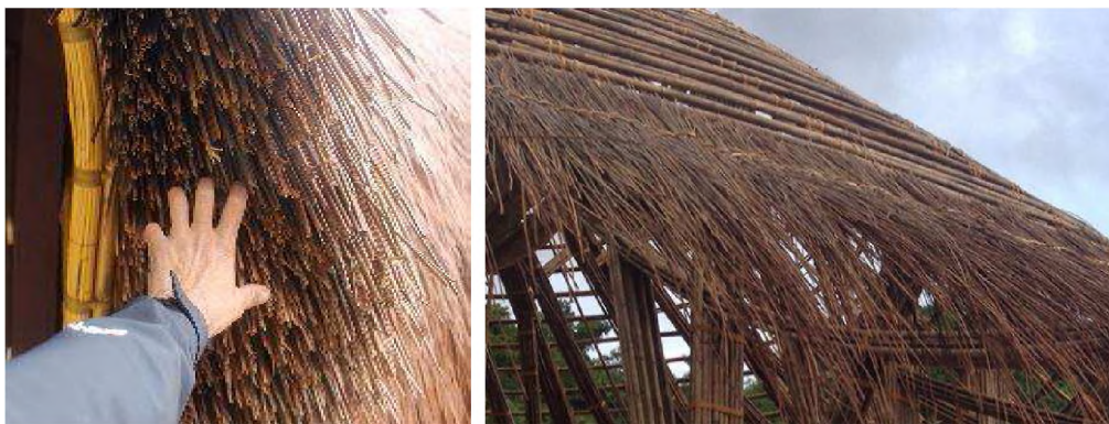
Figura 86: Detalhe da cobertura (esquerda) e iniciando a instalação (direita).
