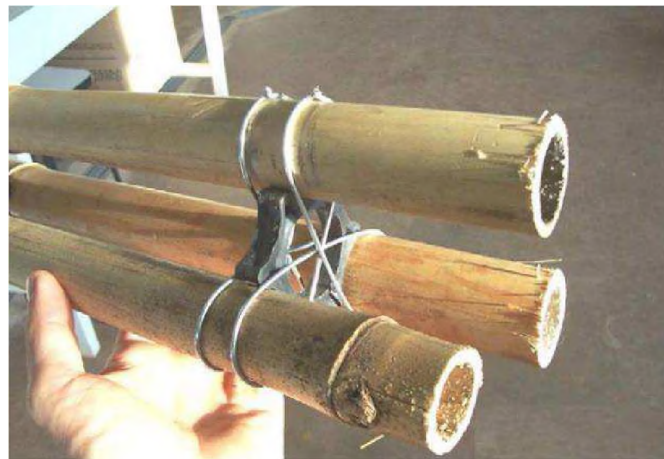
Figura 23: Detalhe da seção da peça composta de bambu. Fonte: Wellington (2007)
