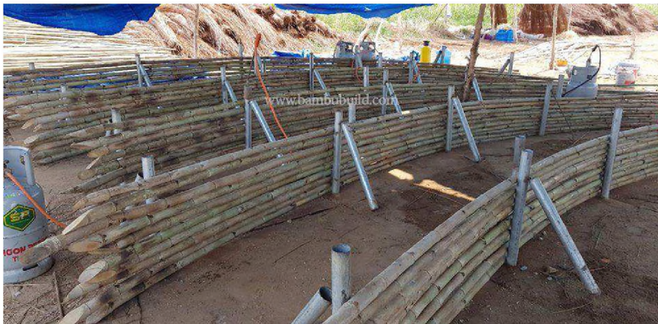
Figura 70: Bambus sendo curvados com auxílio de maçarico para aquecimento.
