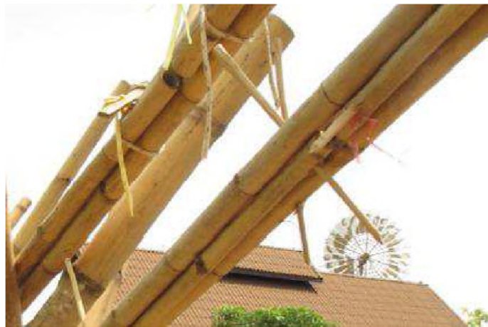
Figura 25: Detalhe do feixe com bambu da espécie Dendrocalamus strictus .
