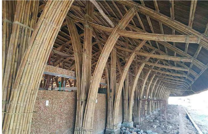
Figura 32: Detalhe da tesoura sendo posicionada.
