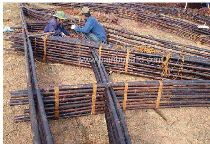
Figura 81: bambus recém colhidos posicionados em gabarito.
