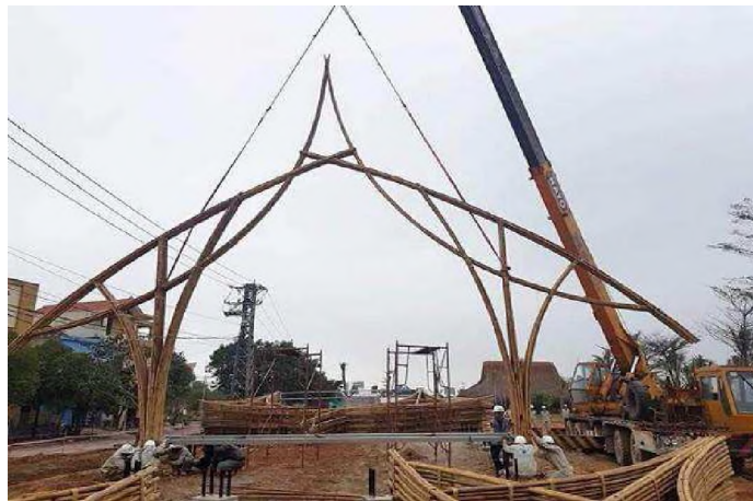
Figura 31: Detalhe da tesoura sendo posicionada. Fonte: http://www.bambubuild.com/en/ .
