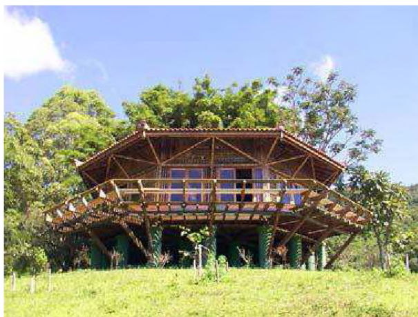
Figura 8: Construção executada com Phylostachys pubescens .
