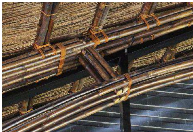
Figura 77: Detalhe das ligações com pinos e cordas de nylon. Fonte: Bambuild, 2017
