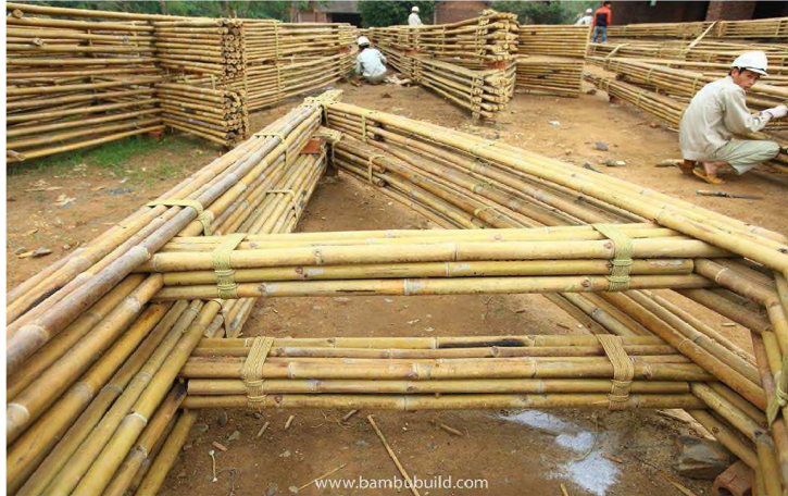
Figura 82: bambus recém colhidos posicionados em gabarito.
