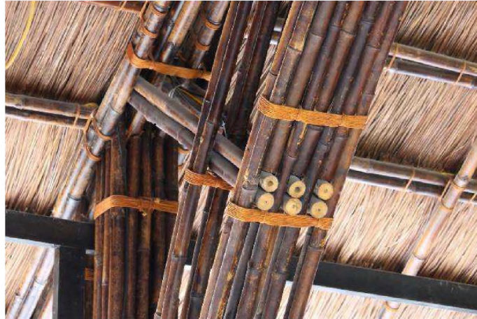
Figura 75: Detalhe das ligações com pinos e cordas de nylon. Fonte: Bambuild, 2017
