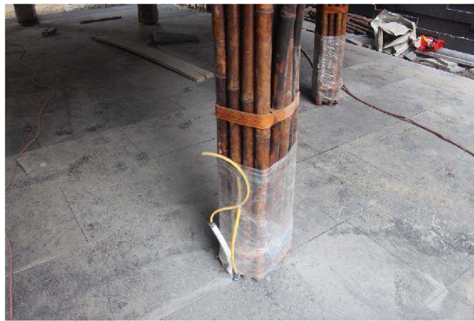
Figura 78: Detalhe da fundação – Foto do autor, obra Bambuild
