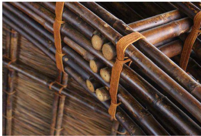
Figura 76: Detalhe das ligações com pinos e cordas de nylon. Fonte: Bambuild, 2017
