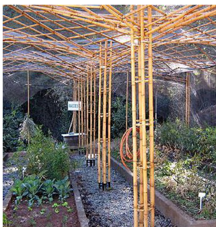
Figura 9: Construção de viveiro com a espécie Phylostachys aurea .
