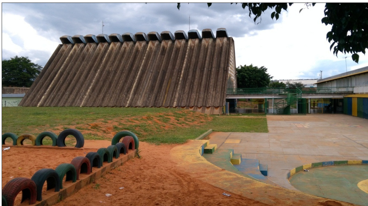
Figura 7. Fotografia da parte lateral do ginásio e do pátio de entrada da escola
