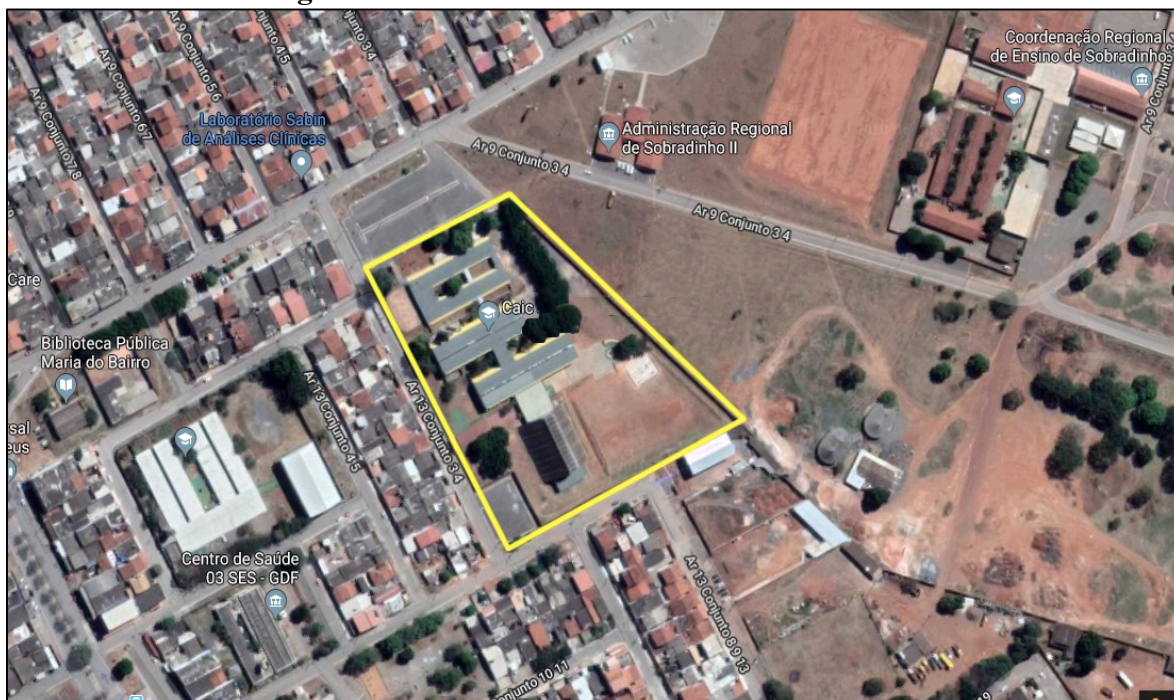
Figura 1. Tomada aérea do CAIC de Sobradinho II
