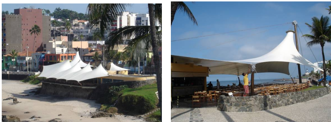
Figura 2.13: Exemplo de estrutura de membrana no Brasil: Restaurante Barra Vento, Salvador 1 .
