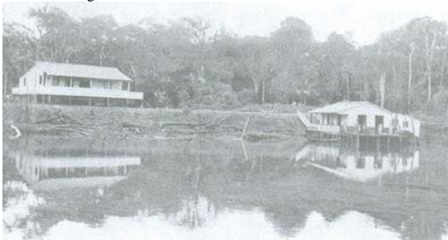
Figura 2. Barracão de um aviador a beira do rio no Pará.
