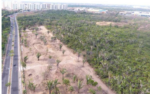
Figura 07: Vista parcial das obras nas bordas do PE do Rangedor, São Luís – MA.
