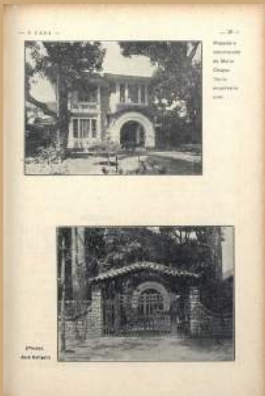
Figura 152: “Projecto e construção Mario Chagas Doria, engenheiro civil”. A influência provençal percebida pelo revestimento de pedras rústicas e arremate de telhas acima do arco de acesso é mesclada com referências renascentistas. Fonte: A CASA. Rio de Janeiro, n. 74, jun. 1930, p. 39.
