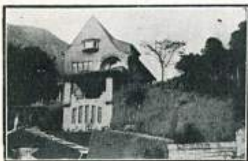
Residência á Rua Marechal Pires Ferreira No. 47 — Laranjeiras — Rio de Janeiro, que encontra-se ao abrigo do calor e do frio. Está protegida com Celotex.
