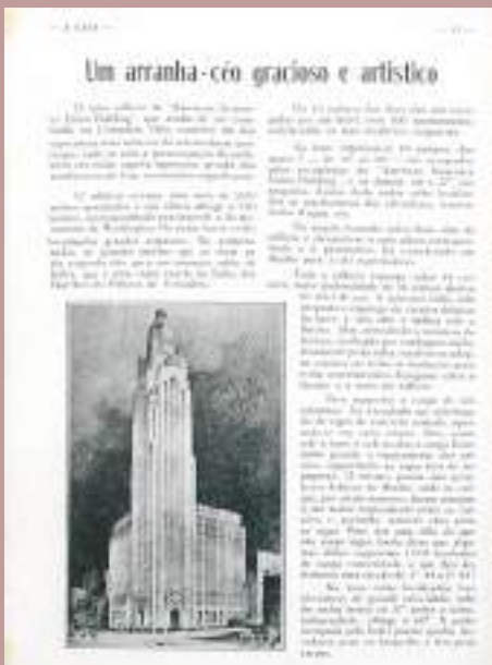
Figura 43: Grande arranha-céu construído em Ohio, o artigo destaca as questões estruturais mais significativas sobre o edifício. Fonte: A CASA. Rio de Janeiro, n. 23, mar. 1926, p. 13.
