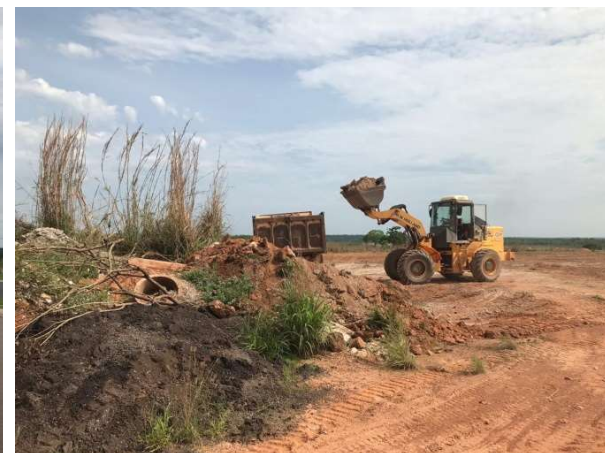
Foto nº 41 obras do Edifício da Sede do Fórum da Comarca de Várzea Grande
