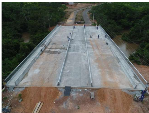
Foto nº 37. Finalização da obra da ponte sobre o Rio Pari, acesso ao IFMT, UFMT, PQT
