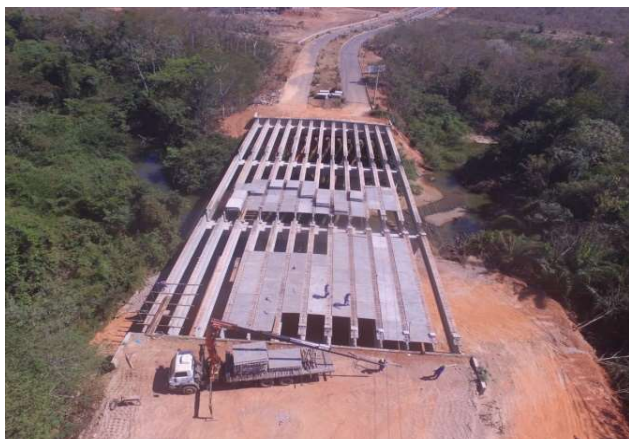
Foto nº 36 Obra da ponte sobre o Rio Pari, acesso ao IFMT, UFMT, PQT
