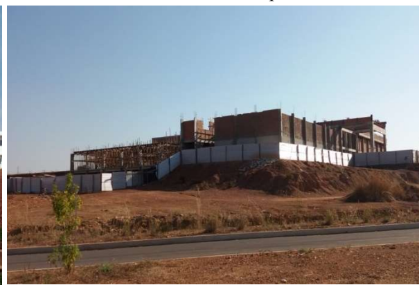
Foto nº 39. Obras - IFMT, campus Várzea Grande
