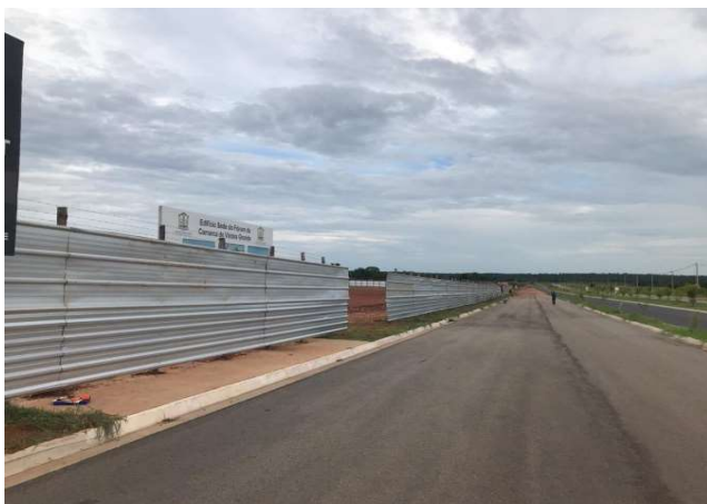
Foto nº 40 Área delimitada para obras do Edifício da Sede do Fórum da Comarca de VG
