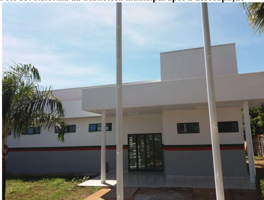
Foto 33. Reforma da Biblioteca municipal após a desocupação
