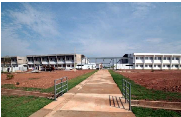
Foto nº 38. Obras - UFMT, campus Várzea Grande
