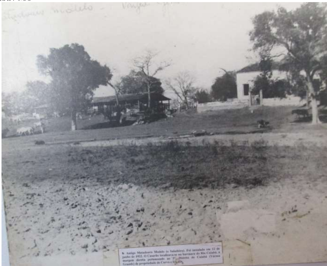
Foto 24. Antigo “Matadouro Modelo” (o Saladeiro), Instalação 1922, localizado no 3º distrito de Cuiabá / MT
