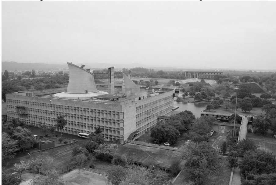
Figura 18 – Centro Governamental de Chandigarh.
