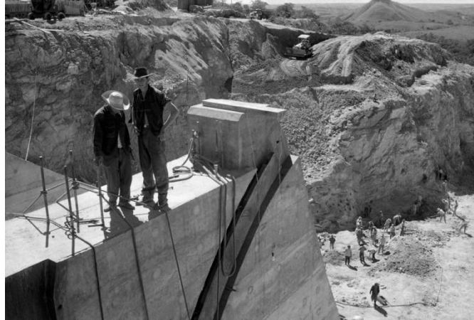
Figura 28 – Brasília em obras, 1960. Foto: René Burri.
