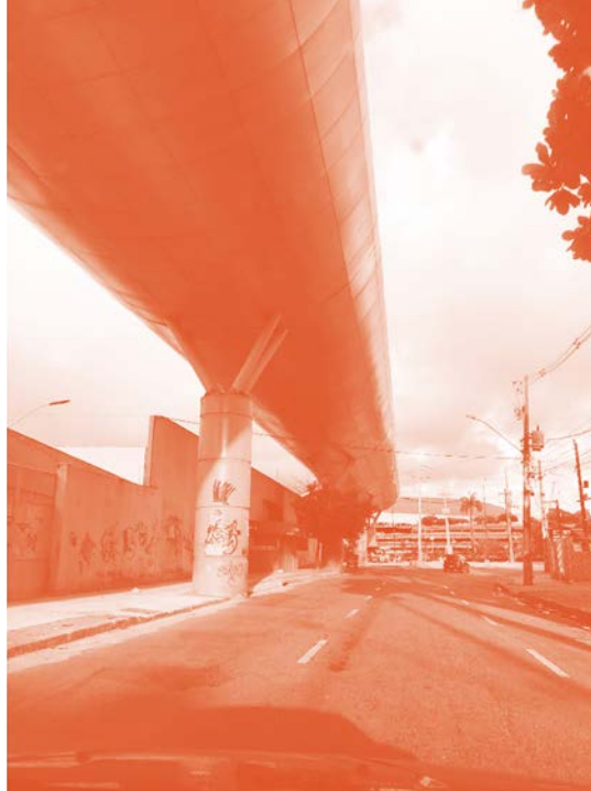
Figura 3.226: Passarela de Integração Aeroporto – Metrô – Fonte: Anderson Ferreira, 2019.
