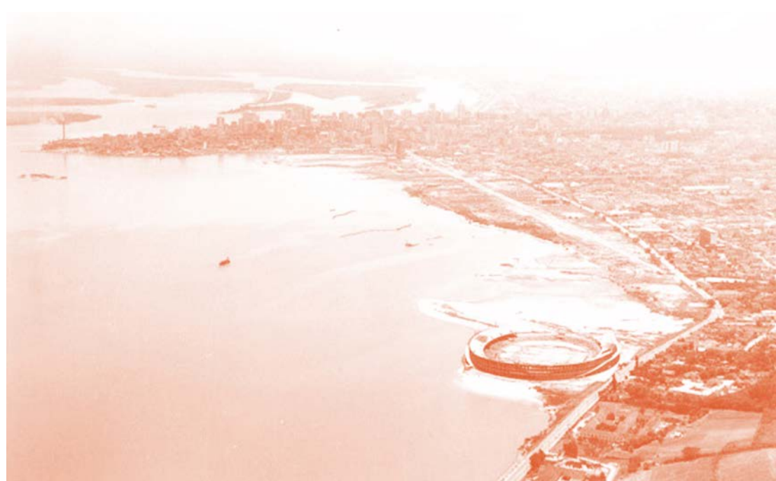
Figura 3.189: Estádio Beira Rio em construção na década de 1960 – Fonte: Internacional.com.br.
