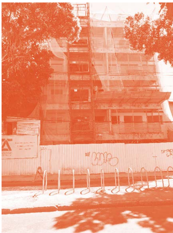
Figura 3.248: Imóveis para comercialização – Fonte: Anderson Ferreira, 2017.
