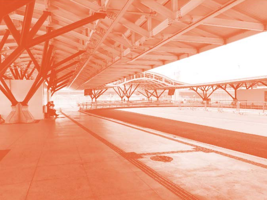
Figura 3.254: Estação de Acesso ao BRT - Fonte: Anderson Ferreira, 2017.
