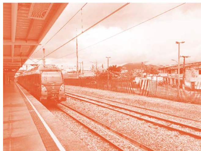
Figura 3.129: Estação Carlito Benevides, Maracanaú. Fonte: Anderson Ferreira, 2019.
