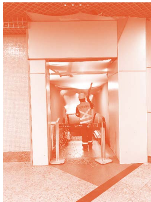
Figura 3.274: Obras nas áreas de embarque e praça de alimentação, 02/2019 - Fonte: Anderson Ferreira, 2019. Figura 3.276: Obras nas áreas de embarque e praça de alimentação, 02/2019 - Fonte: Anderson Ferreira, 2019.
