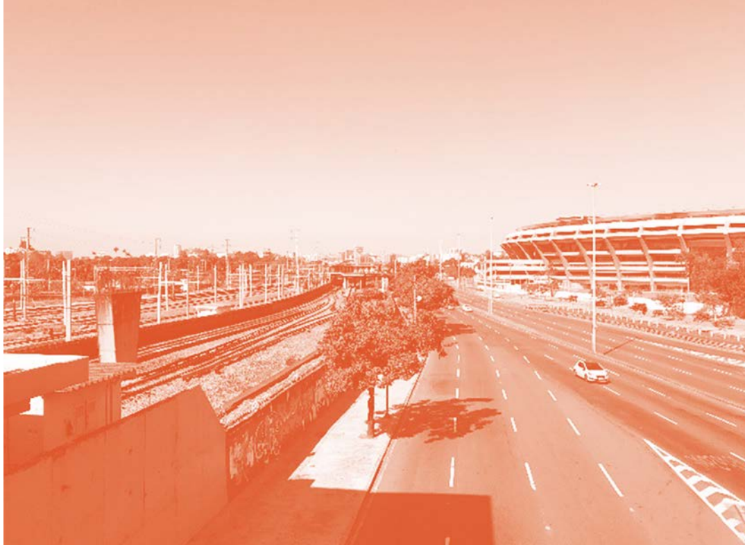
Figura 3.237: Maracanã, Radial Oeste e Linha Férrea – Fonte: Anderson Ferreira, 2019.
