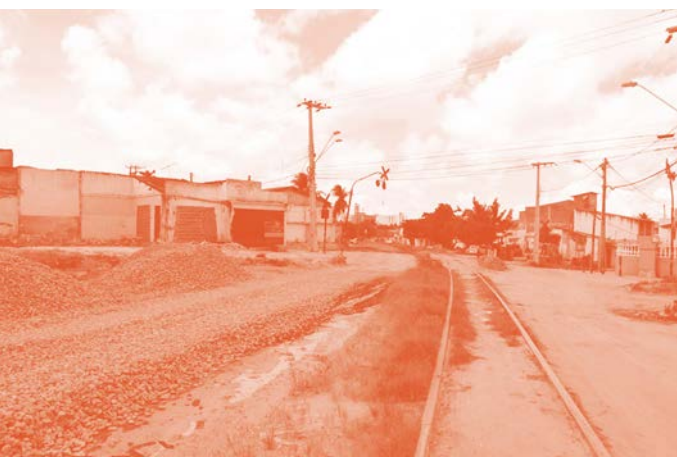
Figura 3.121: Construção da nova linha do VLT, ladeada pela antiga linha da RFFSA - Fonte: < https://www.seinfra.ce.gov.br/2018/03/09/vlt-parangaba-mucuripe-secretario-e-equipe-visitam-varias-frentes-da-obra/ >.
