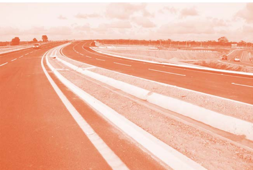
Figura 3.172: Pista do acesso Sul ao Aeroporto de São Gonçalo do Amarante, 2016 - Fonte: < http://www.senadinhosga.com/pista-de-acesso-sul-ao-aeroporto-de-sao-goncalo-esta-90-concluida/ >.
