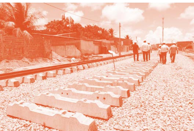
Figura 3.120: Construção linha do VLT - Fonte: seinfra.ce.gov.br <https://www.seinfra.ce.gov.br/2018/03/09/vlt-parangaba-mucuripe-secretario-e-equipe-visitam-varias-frentes-da-obra/> .
