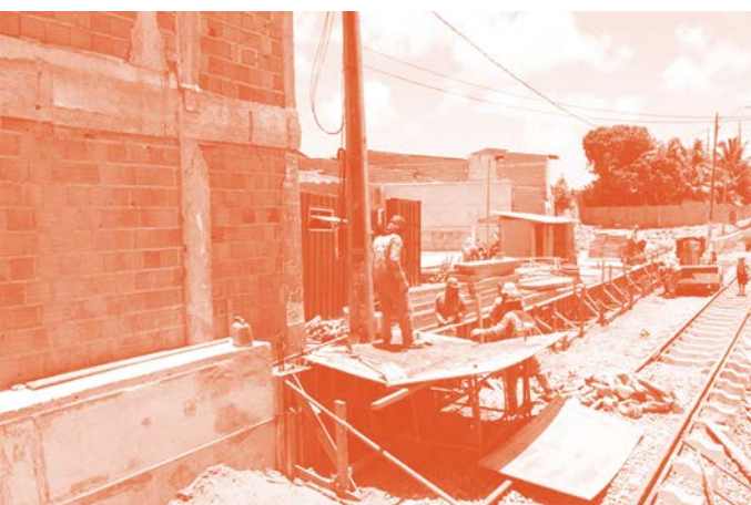
Figura 3.122: Construção dos muros de contenção e limites entre casas e linha do VLT - Fonte: < https://www.seinfra.ce.gov.br/2018/03/09/vlt-parangaba-mucuripe-secretario-e-equipe-visitam-varias-frentes-da-obra/ >.
