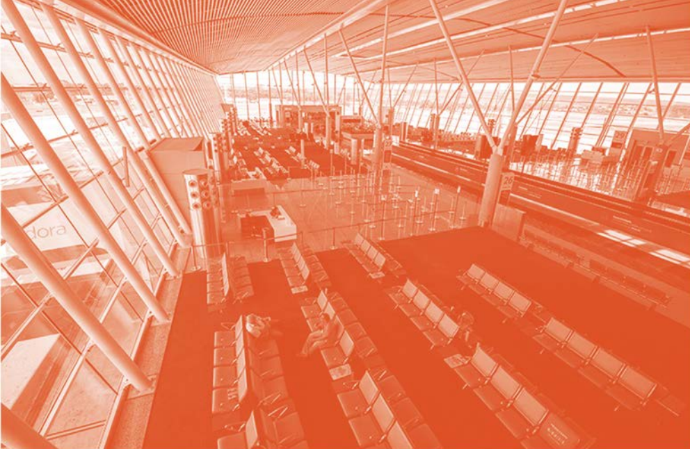
Figura 3.46: Novo terminal de passageiros / expansão – Fonte: Infra-merica.
