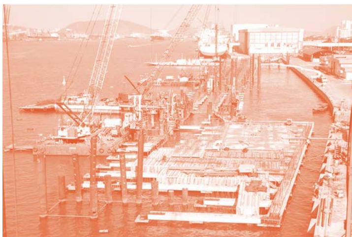
Figura 3.298: Obras de Alinhamento do Cais de Outeirinhos. Fonte: Constran.com.br.
