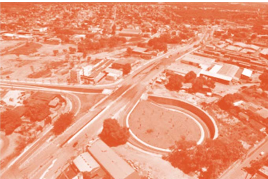
Figura 3.67: Trincheira da avenida Ciriaco Cândia – Fonte: < https://www.midianews.com.br/cuiaba-2014/duplicacao-da-ponte-mario-andreazza-entra-na-fase-final/138018 >.
