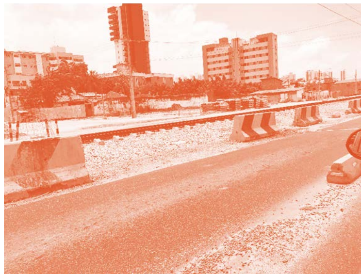
Figura 3.116: Trilhos do VLT em finalização na zona portuária - Fonte: Anderson Ferreira, 2019.
