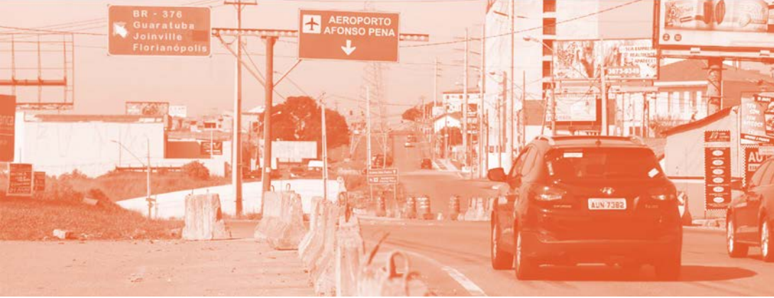
Figura 3.85: Corredor Aeroporto / Rodoferroviária com obras paralisadas – Fonte: < https://www.tribunapr.com.br/noticias/curitiba-regiao/governo-do-estado-tem-tres-meses-para-terminar-obras-da-copa-determina-tce/ >.
