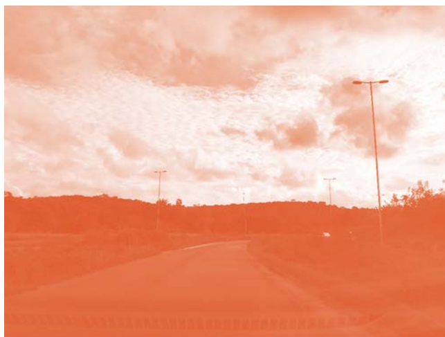
Figura 3.215: Ramal da Copa – Fonte: Anderson Ferreira, 2019.
