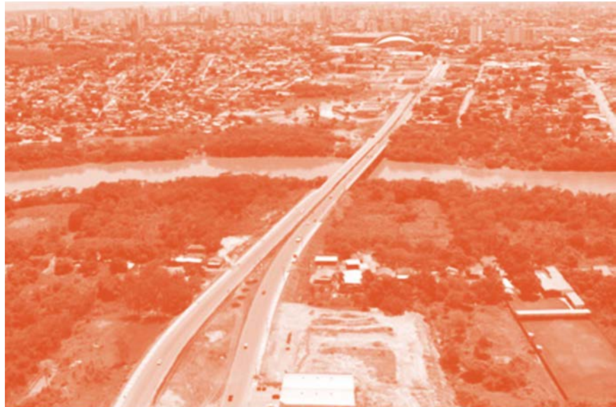
Figura 3.68: Via duplicata e Ponte Mário Andreazza – Fonte: < https://www.midianews.com.br/cuiaba-2014/duplicacao-da-ponte-mario-andreazza-entra-na-fase-final/138018 >.
