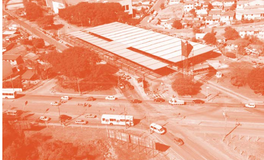
Figura 3.89: Terminal Santa Cândida - Fonte: diariodotransporte.com.br .
