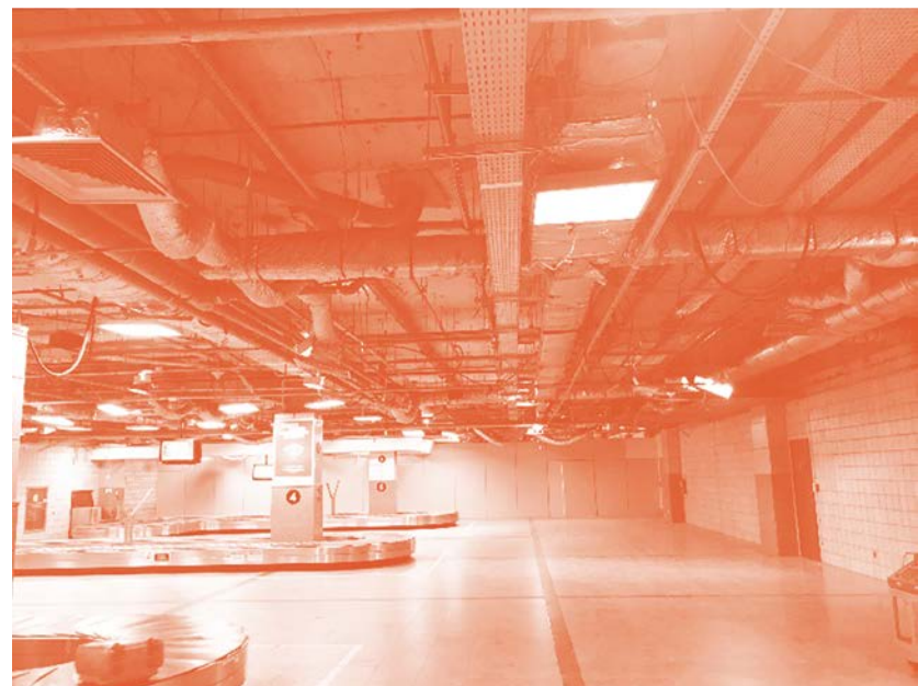
Figura 3.270: Obras nas áreas de desembarque e retirada de bagagens, 02/2019 - Fonte: Anderson Ferreira, 2019.
