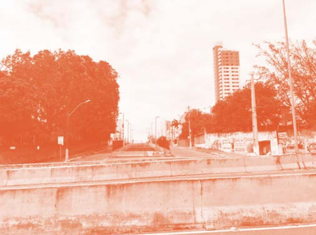
Figura 3.169: Limitadores de cruzamento na Avenida Lima e Silva e Trincheira da Avenida Romualdo Galvão - Fonte: Anderson Ferreira, 2017.
