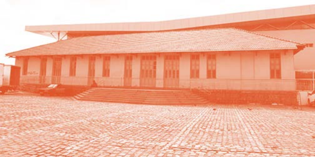
Figura 3.177: Terminal Marítimo de Passageiros com Frigorífico antigo - Fonte: < 3.1.7.2. REBATIMENTOS NAS PAISAGENS E NAS ESTRUTURAS URBANAS
