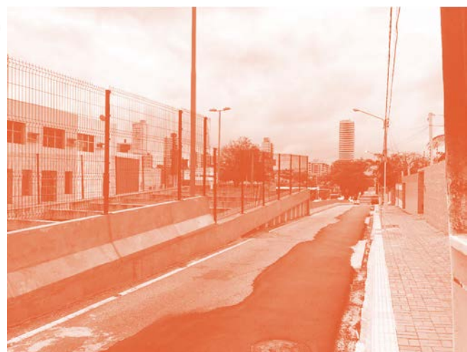
Figura 3.168: Trincheira da Avenida Capitão-Mor Gouveia - Fonte: Anderson Ferreira, 2017.
