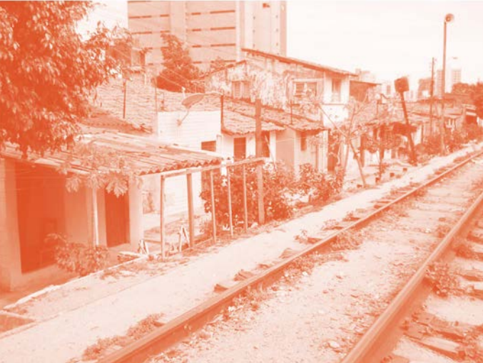
Figura 3.119: Comunidades do Trilho com estrutura antiga da RFFSA - Fonte: < https://www.seinfra.ce.gov.br/2018/03/09/vlt-parangaba-mucuripe-secretario-e-equipe-visitam-varias-frentes-da-obra/ >.
