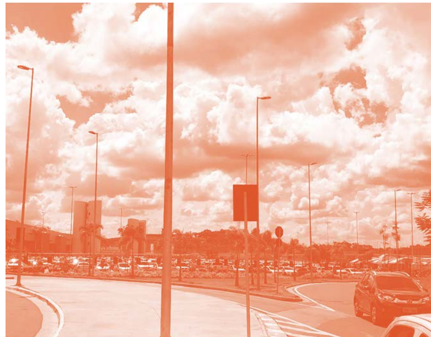
Figura 3.14: Novo Estacionamento – Fonte: Anderson Ferreira, 2019
