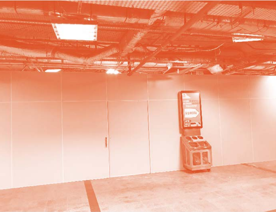
Figura 3.271: Obras nas áreas de desembarque e retirada de bagagens, 02/2019 - Fonte: Anderson Ferreira, 2019.
