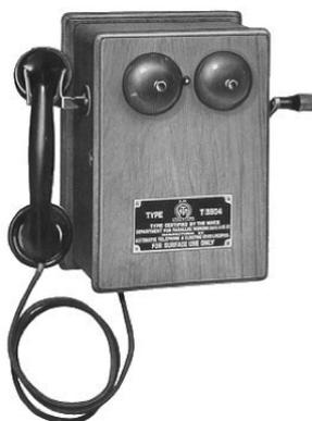
Figura 2.2: Telefone Magnético - Magnetofone [3]
