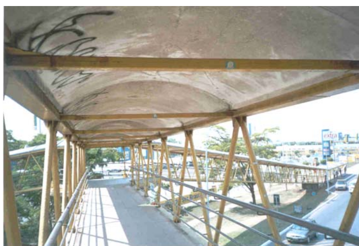
Figura 7.3 – Rampa da passarela sobre a EPIA, vista a partir de trecho horizontal.
