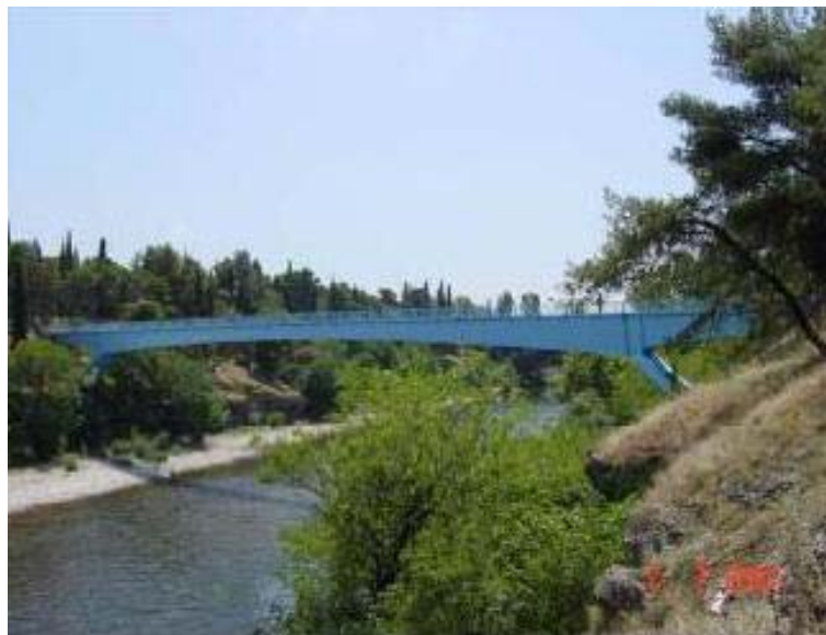
Figura 2.11 – Passarela localizada em Podgorica, Montenegro (Zivanovic et al , 2005a).
