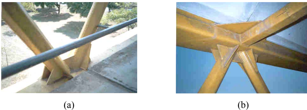
Figura 7.11 – a) Ligação entre banzo inferior e diagonais.
