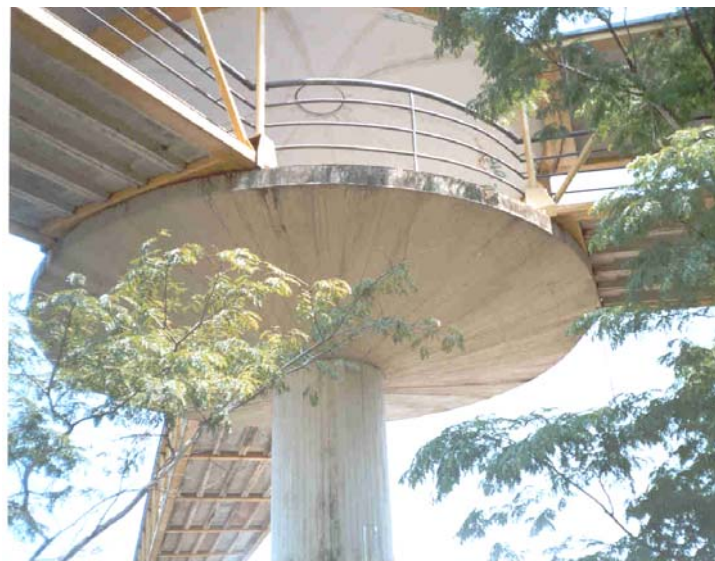
Figura 7.6 – Ligação entre rampas, cogumelo e trecho horizontal.
