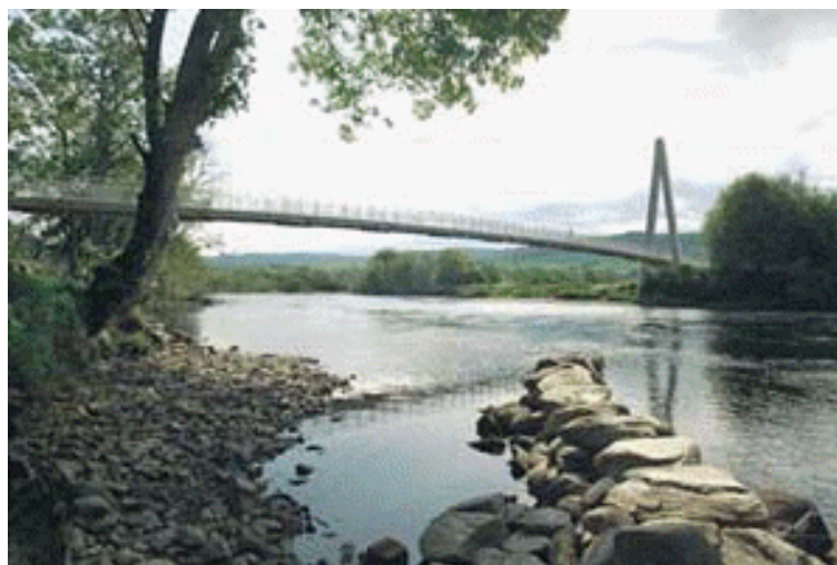
Figura 2.4 – Passarela Aberfeldy, Escócia.
