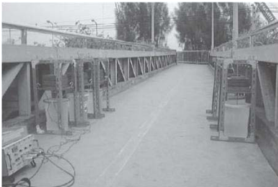
Figura 2.12 – Passarela localizada em Bangkok, Tailândia. Poovarodom et al (2003).
