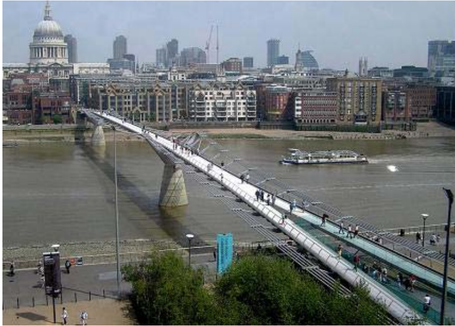
Figura 2.14 – Passarela Millennium. Londres, Inglaterra.
