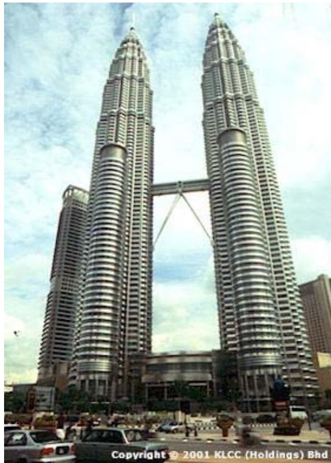
Figura 1.3 – Passarela que liga as torres Petronas. Kuala Lumpur, Malásia.
