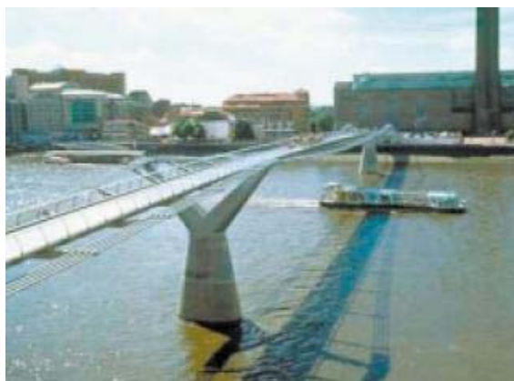
Figura 2.5 – Passarela Millennium. Londres, Inglaterra (Dallard et al , 2001).
