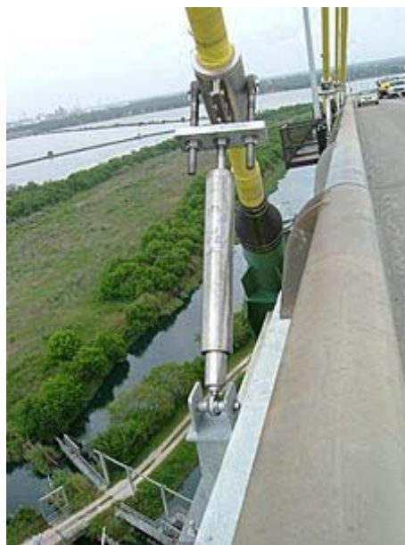
Figura 5.1 - Amortecedor viscofluido aplicado em ponte estaiada.
