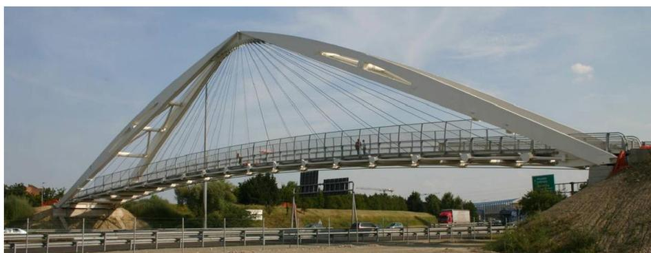
Figura 3.33 – Passarela estaiada em Bolonha, Itália (UBERTINI *et al.*, 2013).
