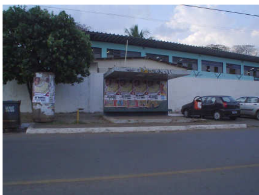
Figura 52 – Abrigo em concreto.
