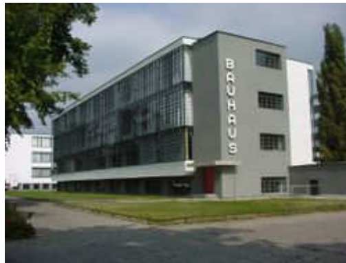
Figura 16 - Sede da Bauhaus em Dessau, Alemanha.
