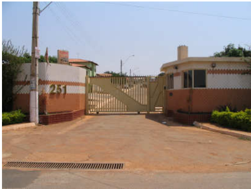
Figuras 32 - Fachada do lote 251 da rua 6.
