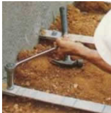
Figura 2.6 Colocação das tiras metálicas (Terra Armada, 2004)
