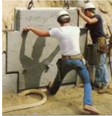
Figura 2.5 Colocação das placas de concreto pré-moldadas (terra Armada, 2004)
