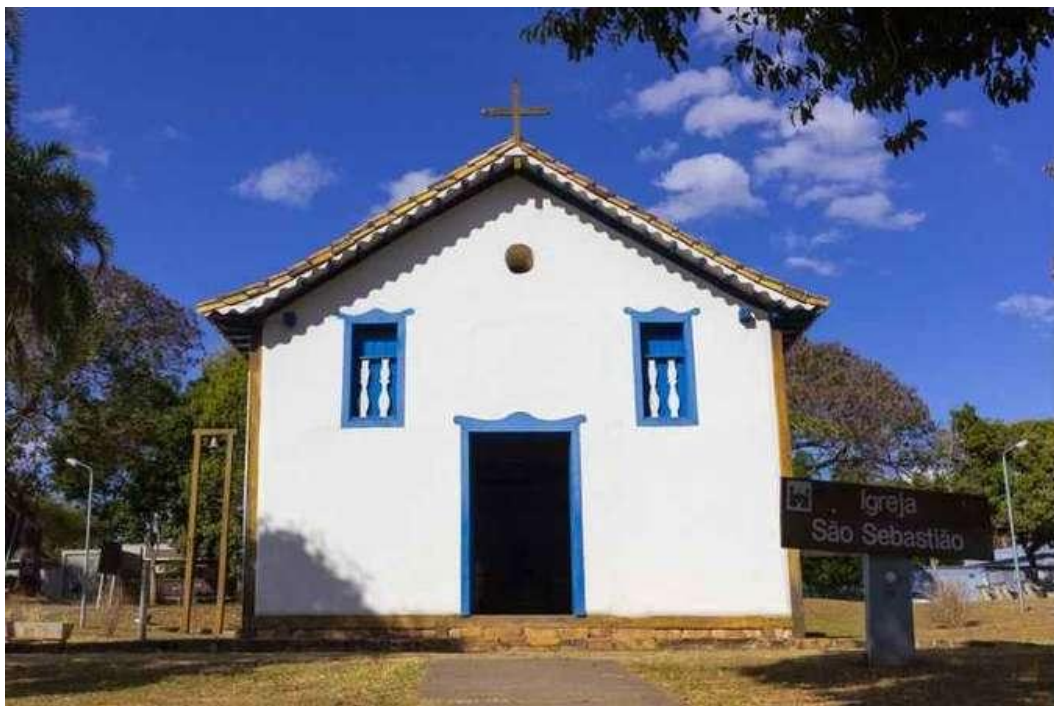
Figura 3: Igreja de São Sebastião.
