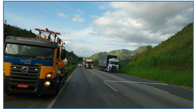
(b) Apoio operacional de caminhão pipa
