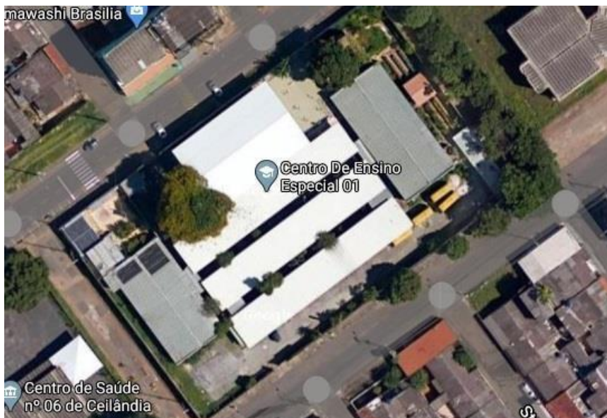
Foto 04: Foto aérea da escola. Fonte Google Maps. Acessado em 15/02/2020.
