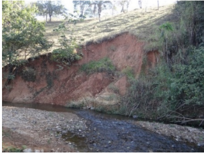
(b) Erosão às margens do Rib. Eng. Velho
