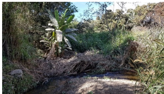
(g) obstruções na calha do Rib. Eng.Velho
