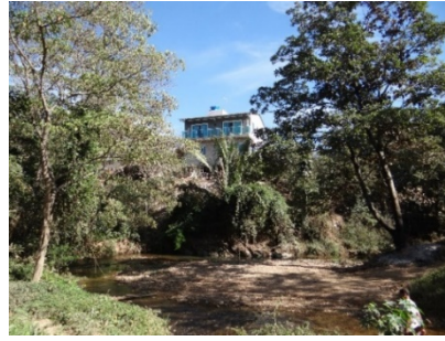
(d) Casa com alto padrão construtivo em área de risco
