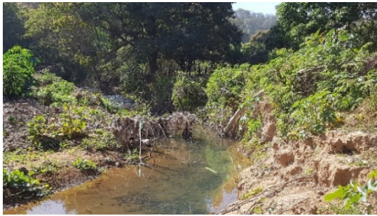
(e) obstruções na calha do Rib. Eng.Velho
