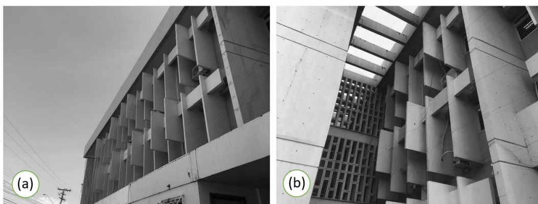
Figura 27 - Envoltória do Fórum Sobral Pinto (a) Fachada Sudoeste; (b) Fachada Nordeste
