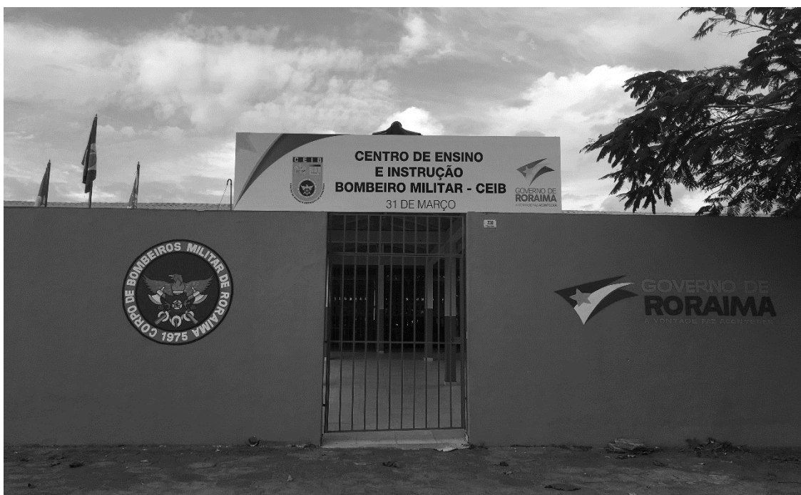
Figura 18 - Fachada da antiga Escola Estadual 31 de Março, Boa Vista/RR
