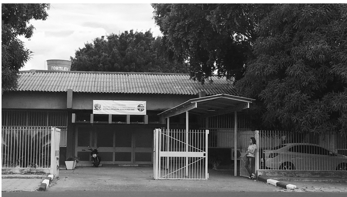
Figura 14 - Fachada principal da Escola Estadual Gonçalves Dias, Boa Vista/RR
