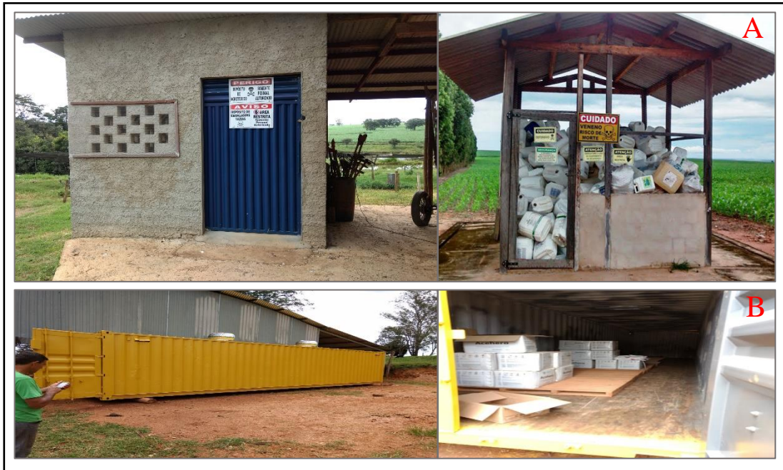
Figura 25 - A) Construção de depósitos de agrotóxicos em duas fazendas certificadas do grupo Cresol Estrada de Ferro; B) Instalação de um trailer para servir de depósito em uma das fazendas certificadas do grupo Cresol Estrada de Ferro. Fonte: Camponesa Socioambiental/Tecnosol
