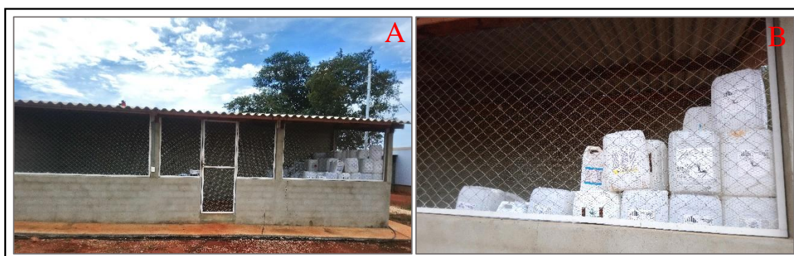
Figura 21 - A) Depósito de armazenamento de agrotóxicos construído na Fazenda Cachoeira; B) Telas de ventilação obrigatórias no depósito de armazenamento de agrotóxicos conforme critérios da certificação RTRS. Trabalho de Campo (2019)
