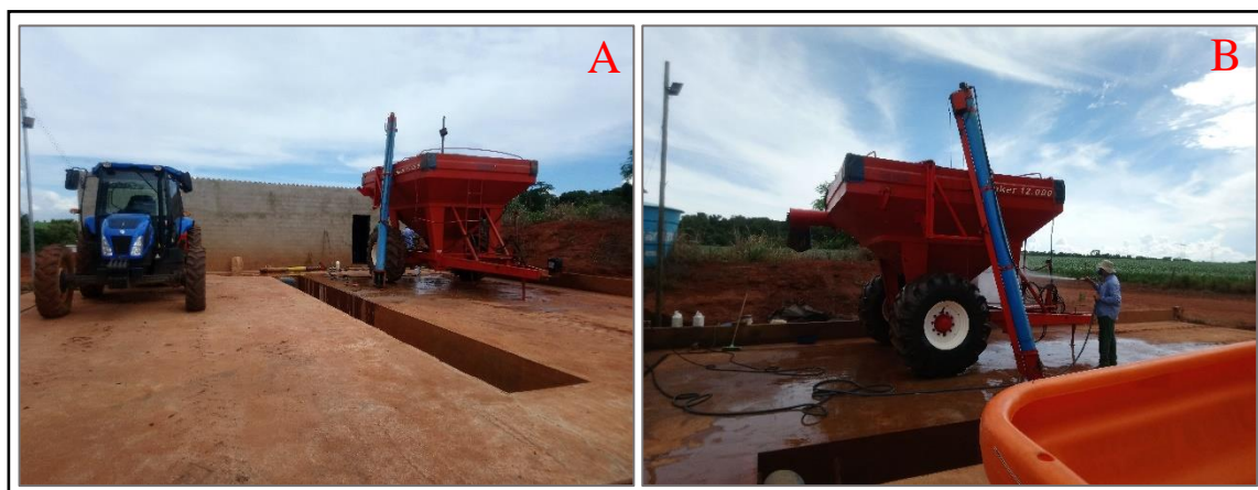
Figura 22 - A) Lavador de veículos construído seguindo às exigências dos critérios RTRS; B) Funcionário da Fazenda Cachoeira realizando a lavagem de uma máquina agrícola. Trabalho de Campo em dez. de 2019
