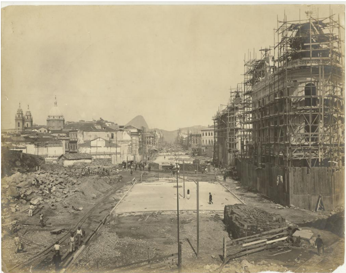
Figura 62: Vista panorâmica da Avenida Central durante os trabalhos de pavimentação, em 1905. Fotografia de Augusto Malta. Fonte: (MUSEU DA REPÚBLICA, 1905).
