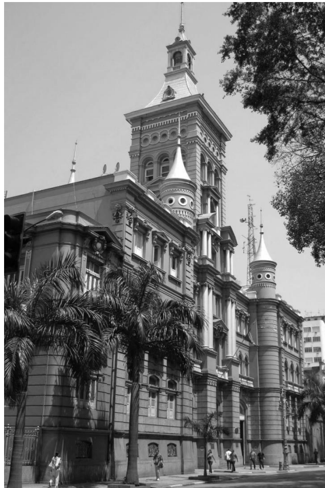
Figura 45: Quartel Central do Corpo de Bombeiros. Fotografia de Halley Pacheco de Oliveira. Fonte: (OLIVEIRA, 2010).
