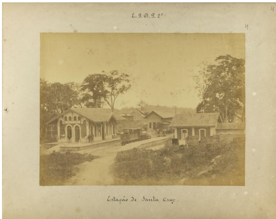
Figura 70: Estação de Santa Cruz da Estrada de Ferro Dom Pedro II (atual Central do Brasil) no século XIX.
