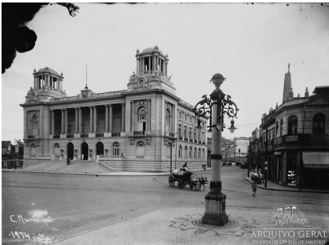
Figura 55: Palácio Pedro Ernesto, Câmara Municipal. Autor desconhecido. Fonte: (AGCRJ, 1914).
