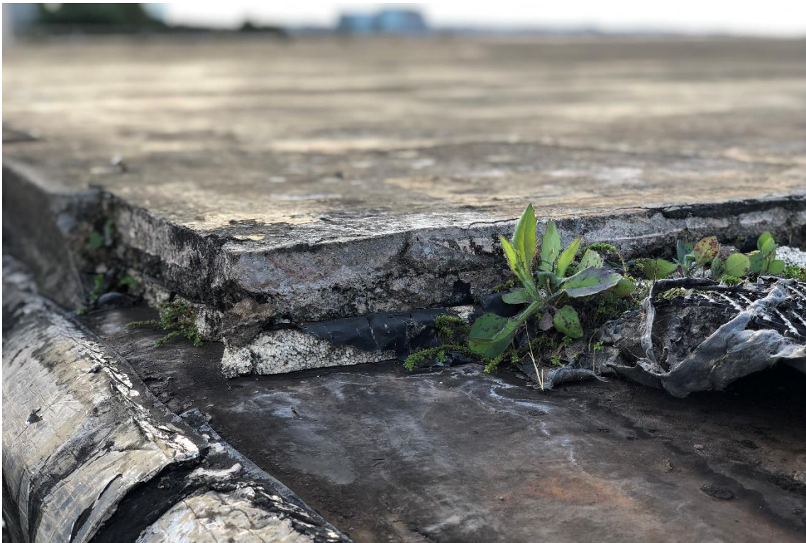
Figura 22 - Camadas dos elementos proteção mecânica, lona, isopor, geocomposto e manta asfáltica, atuais na cobertura do Palácio do Planalto. Fonte: Autor (2019).
