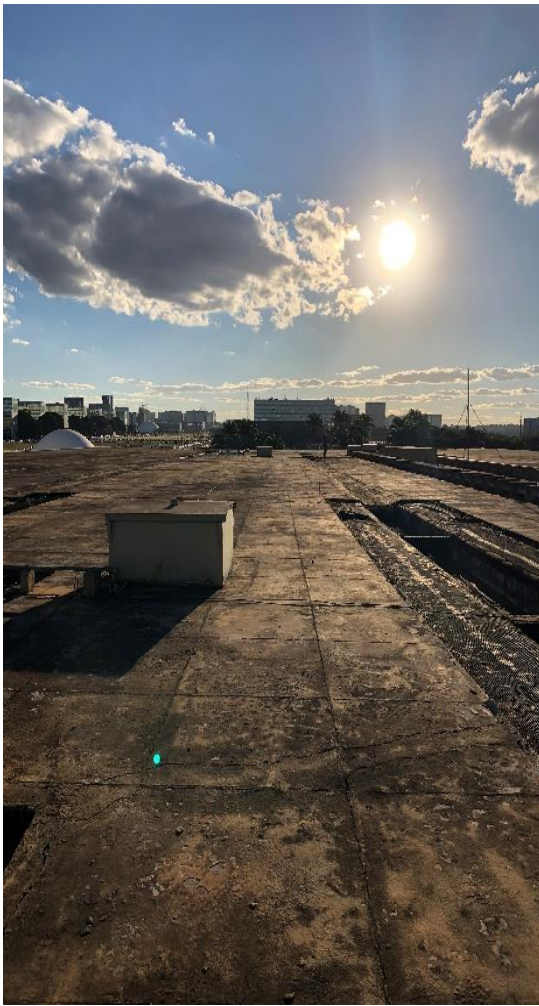
Figura 25 - Calhas interna da Cobertura do Palácio do Planalto. Fonte: Autor (2019).
