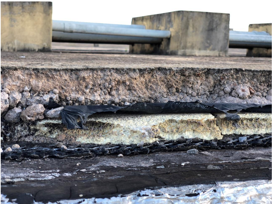
Figura 23 - Camadas dos Elemento de Impermeabilização da Cobertura do Palácio do Planalto. Fonte: Autor (2019)
