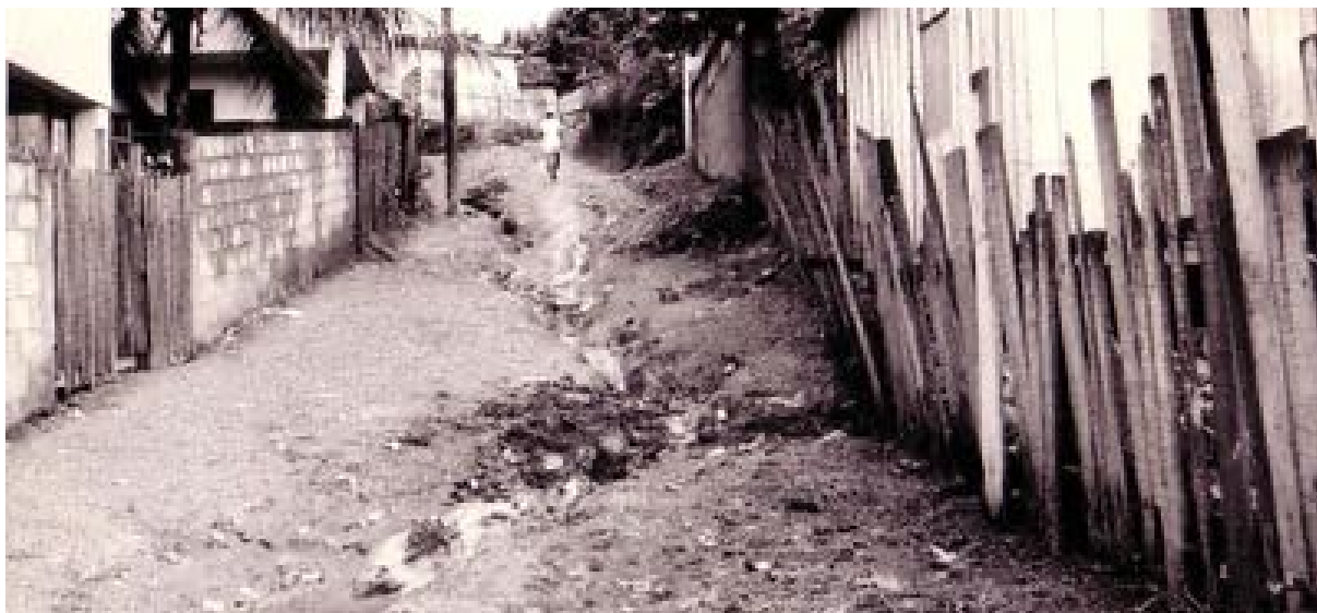
Figura 48: Rua com vala, no bairro Porto Novo em Cariacica
