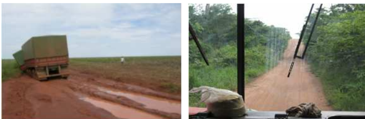
Figura 4.2: Condições das Estradas Utilizadas pelo Transporte Escolar Rural.
