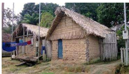
Figura 4. Moradias de Taipa com cobertura de palha. Fonte: Acervo pessoal de Liz Carmem Silva-Pereira, 2014.
