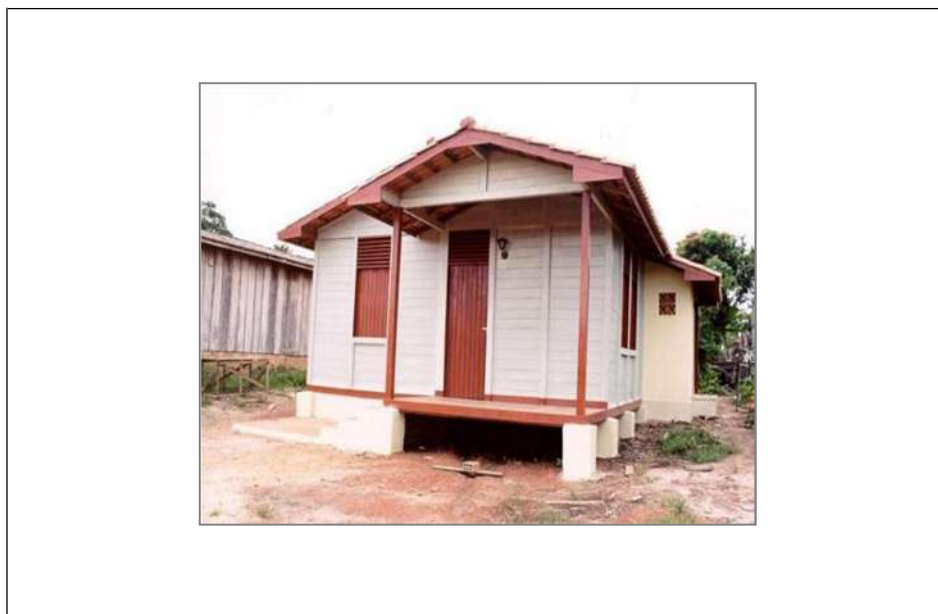
FIGURA 3 - Imagem de uma edificação da “Habitação Popular em Madeira” em Pimenta Bueno, RO
