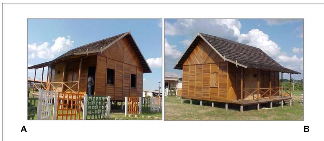
FIGURA 3 - Imagens de protótipo de habitação em madeira, edificada na FUNTAC em 2003
