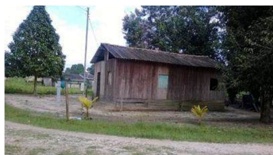
Figura 5 Moradias de Madeira com cobertura em amianto. Fonte: Acervo pessoal de Liz Carmem Silva-Pereira, 2014.
