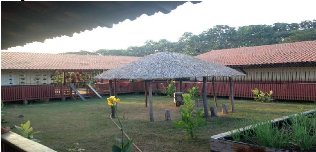
Fotografia 4 - Vista central da Escola São Ciríaco
