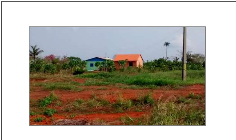
FIGURA 6 - Substituição de casa de madeira por edificação em alvenaria. BR 317, proximidades de Xapuri, Acre. Obra financiada pelo PNHR
