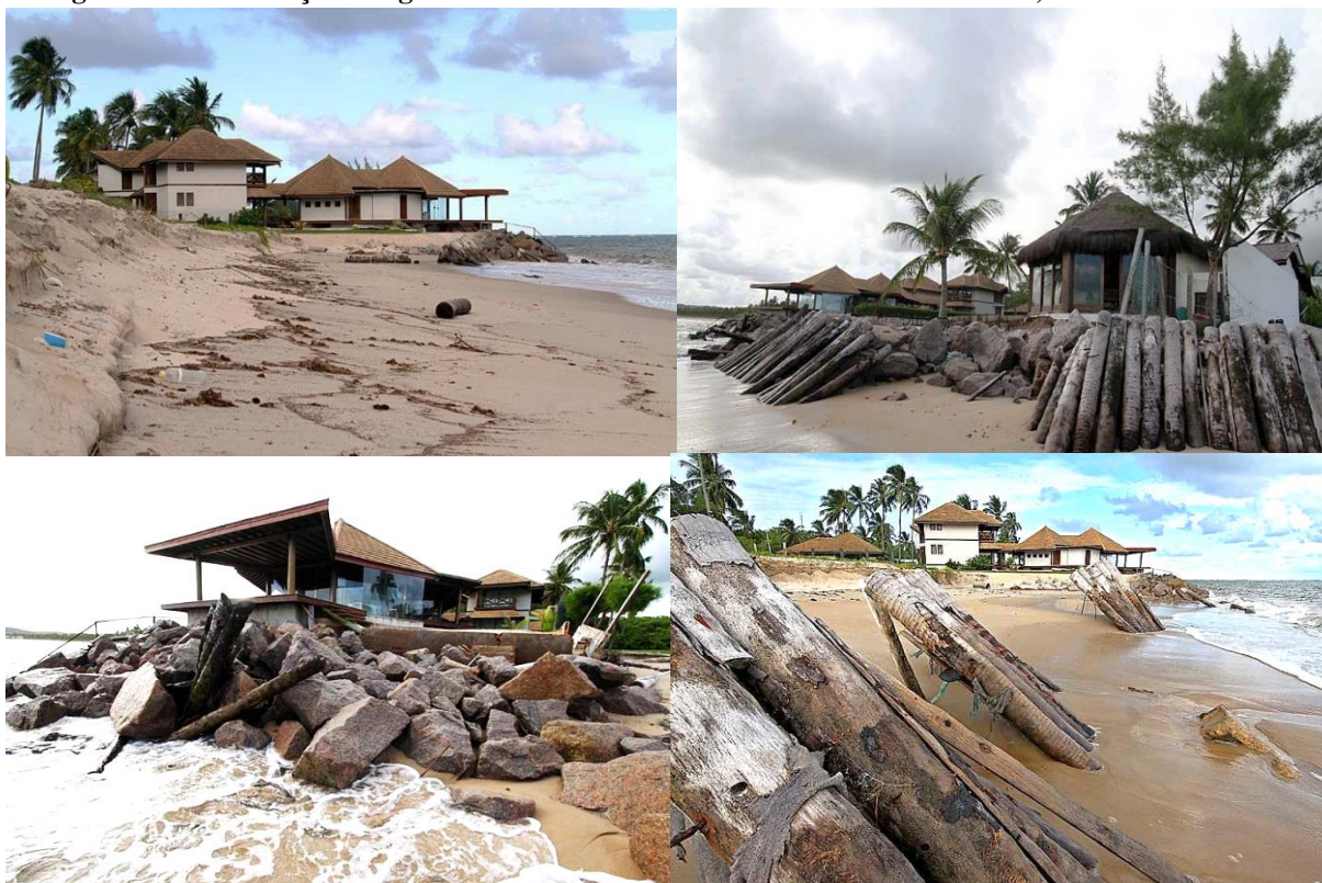
Figura 49 – Construção Irregular na Linha de Costa – Praia de Mamucabinhas, em Tamandaré/PE.
