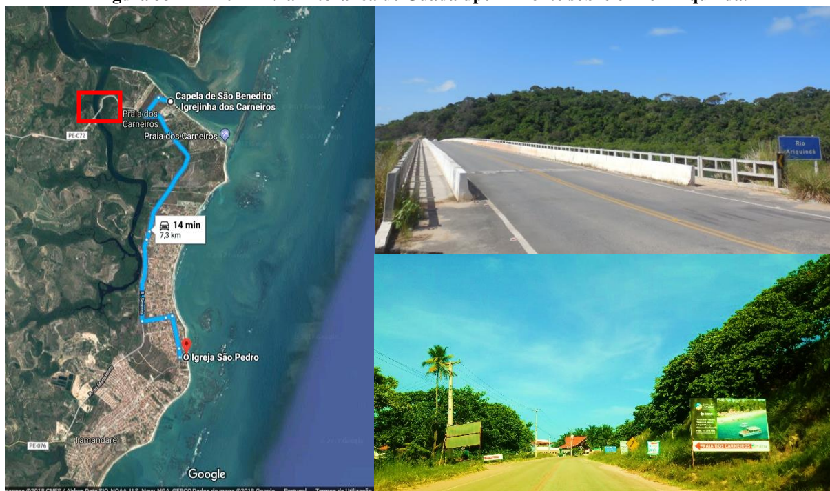
Figura 33 – PE -072 - Via Litorânea de Guadalupe — Ponte sobre o Rio Ariquindá.
