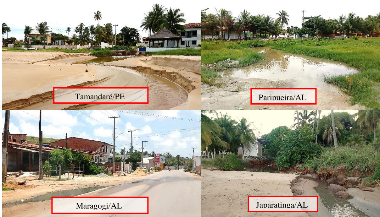
Figura 50 – Despejo de Efluente/Esgoto a céu aberto- APACC.
