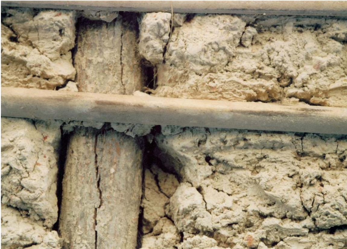
Foto: Prof. Rafael Sanzio dos Anjos. Detalhe parede de Supapo (Pau a pique) no Recôncavo da Bahia. Cahoeira – Bahia. 2017.
