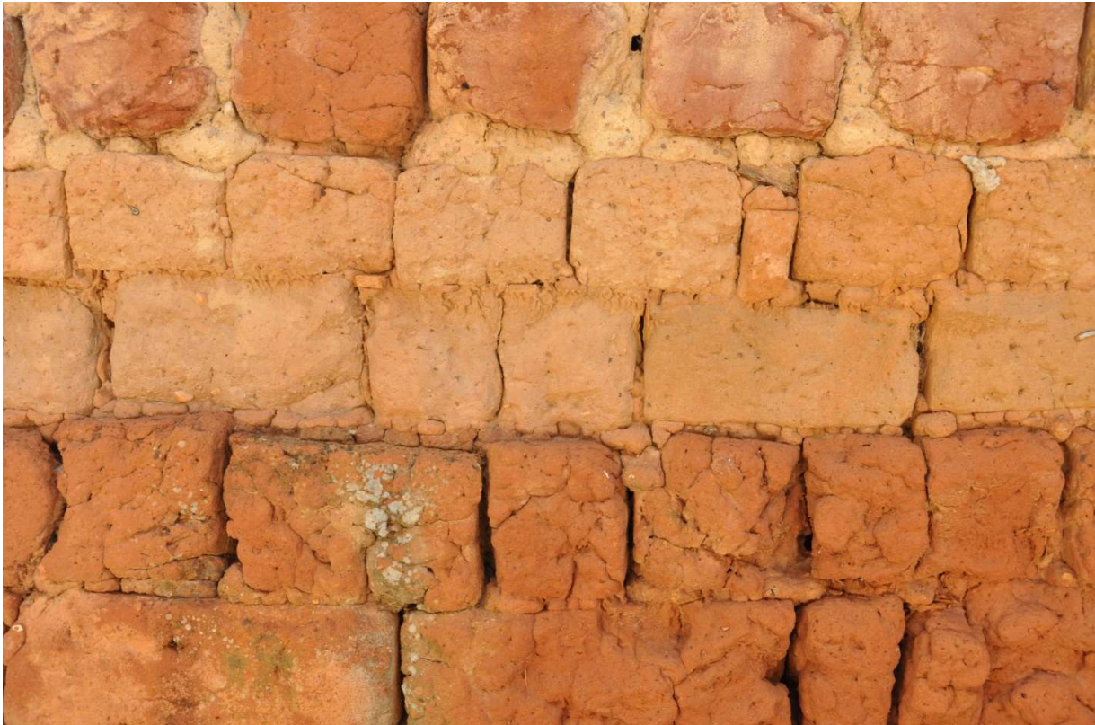
Foto: Prof. Rafael Sanzio dos Anjos. Detalhe parede de adobe . Pirenópolis – Goiás, 2015.
