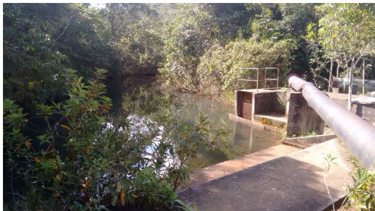
Foto 4.2.1.1 – Captação de água da CAESB no córrego Brejinho, na Estação Ecológica de Águas Emendadas, em Planaltina/DF
