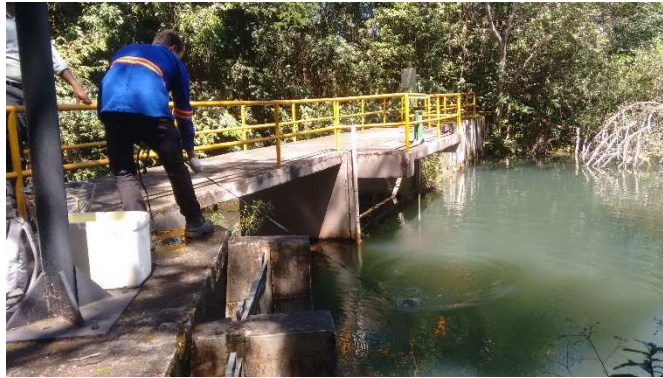
Ponto 5 - Captação de água da Caesb no Córrego Fumal
