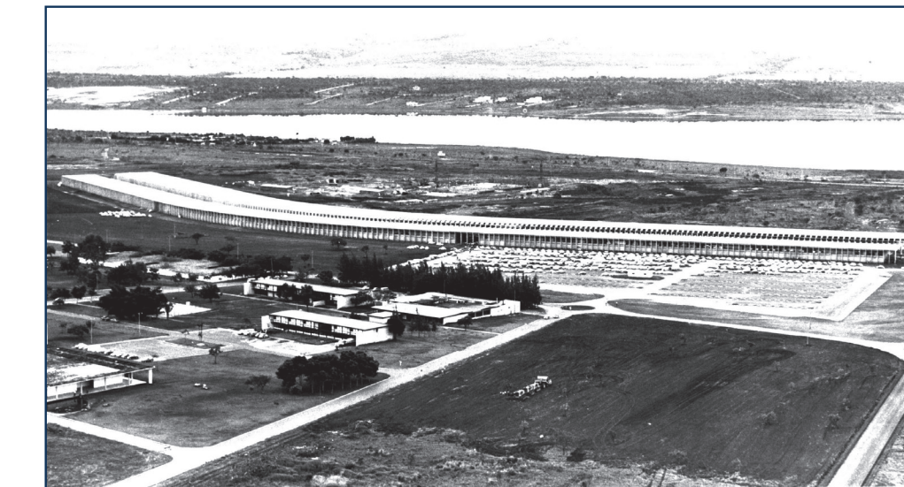
A construção do ICC (Instituto Central de Ciências), o “minhocão”. A síntese do projeto da UnB. Fonte: CEDOC UnB.
